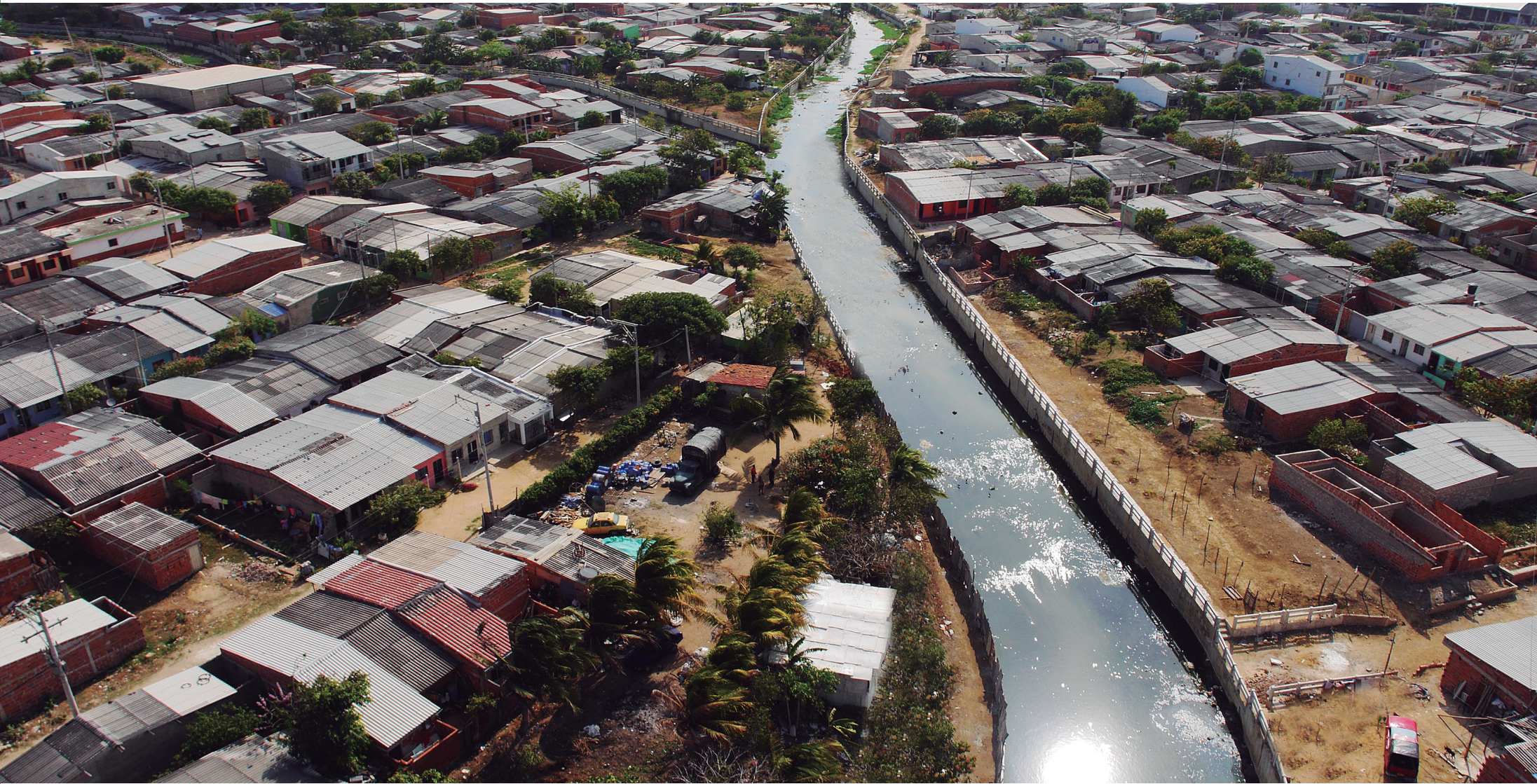
▲ Canalización arroyo Los Angeles.
