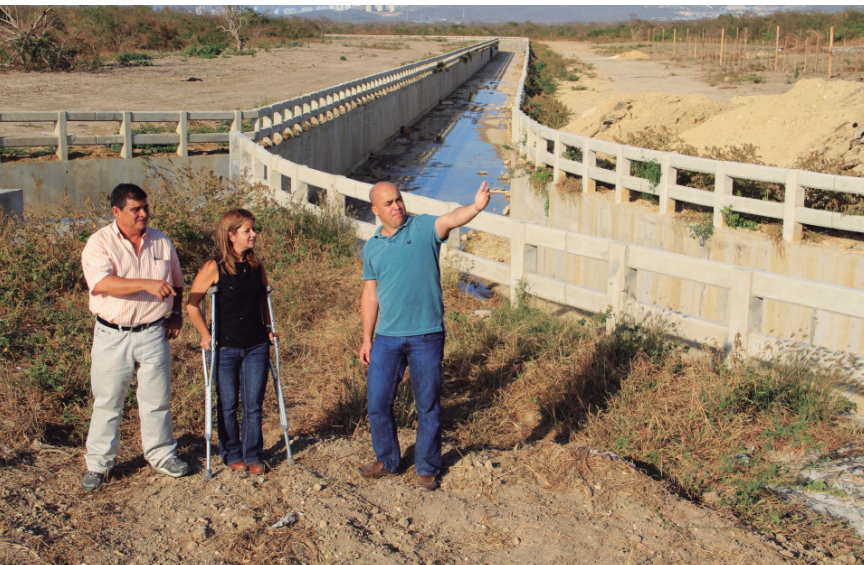
▲ Canalización arroyo Las Cayenas.
