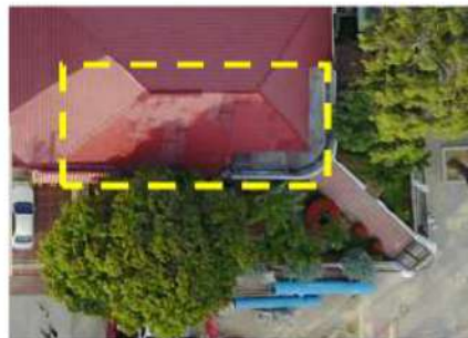
Reposición de tejas en mal estado.
