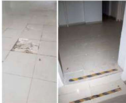
Mantenimiento de pisos y reposición de piezas en mal estado
