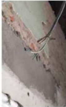
Mantenimiento de cableado de redes.
