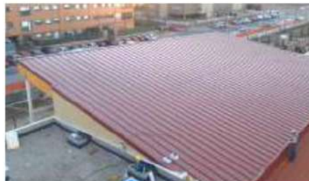
CUBIERTA TIPO SAND WICH PROPUESTA
