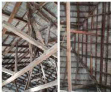
Mantenimiento a la estructura de la cubierta
