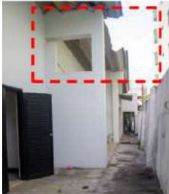
Limpieza y mantenimiento de cubierta y viga canal y reposición de teja de cubierta averiadas
