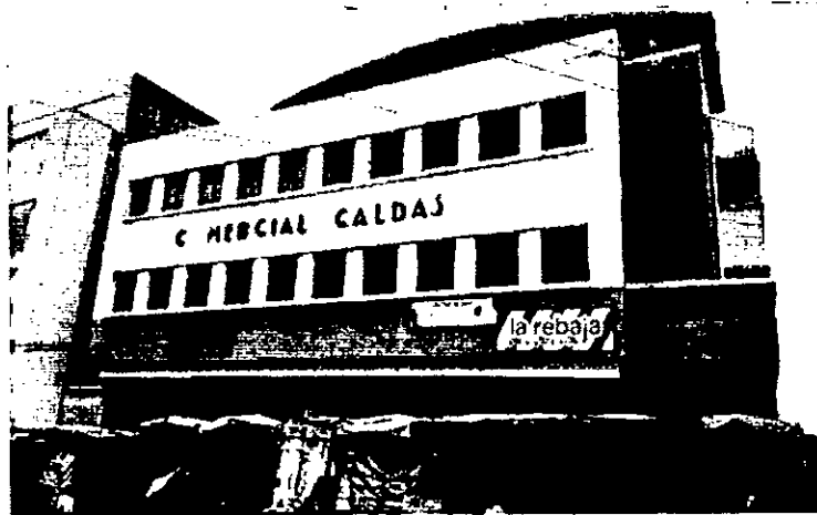
• APLICACIÓN DE PINTURA GENERAL FACHADA ACTUAL
