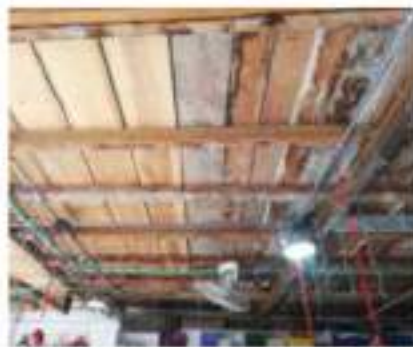
LIBERACION CHAZAS (ENTRE PISO)
