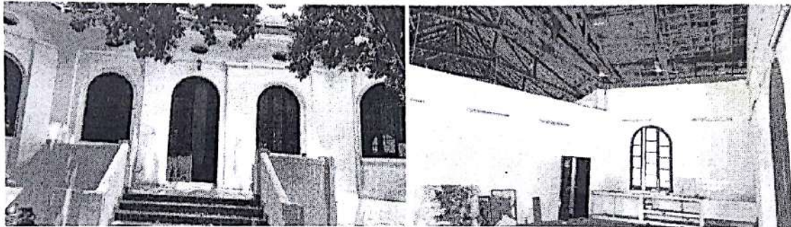
ESTADO ACUAL ACTUAL BLOQUE 6 - ARTES PLASTICAS
