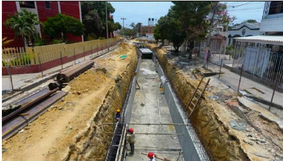
Foto 3. Ejecución de las obras de canalización del arroyo de la Carrera 21
