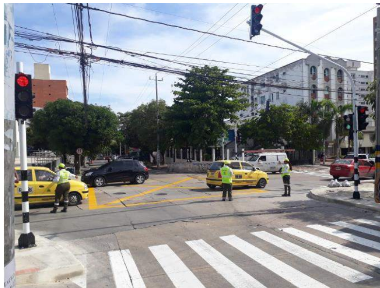
Foto 5. Intersección semaforizada en la calle 79 con Carrera 42H
