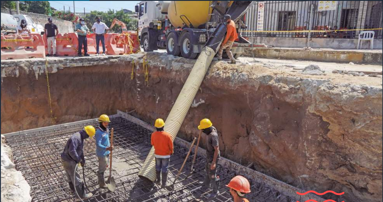
Canalización de arroyo La Felicidad.
