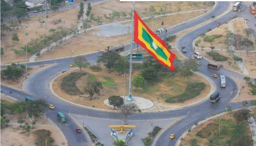
Ilustración 13 Glorieta del Monumento a la Bandera localizado en la entrada del puente Pumarejo
