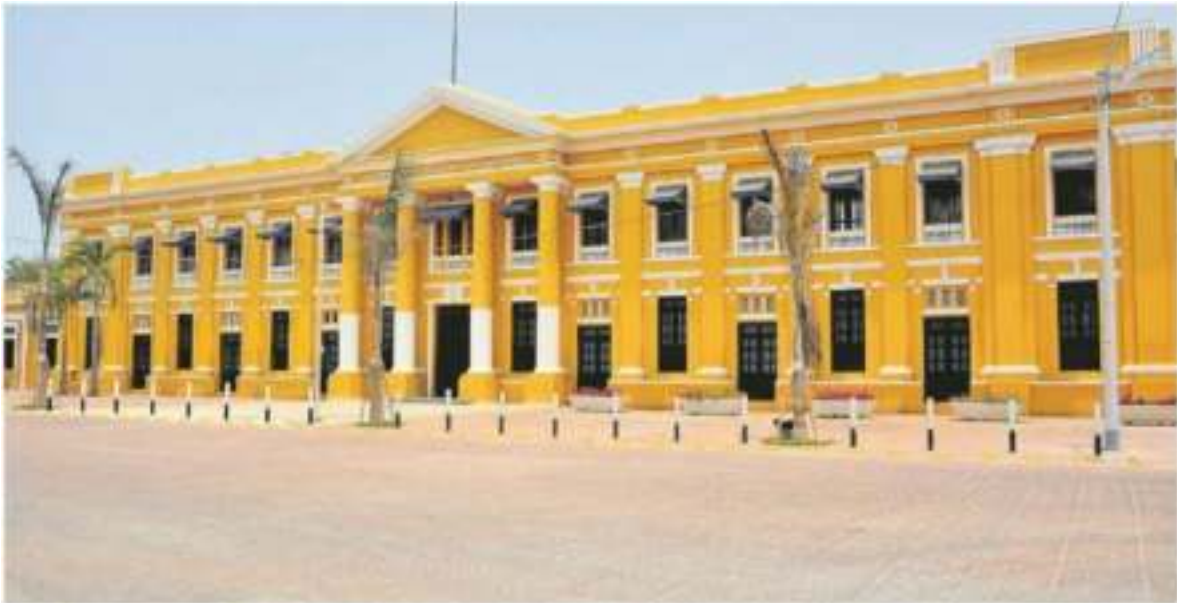
Figura 18. Foto Actual del Edificio de la Aduana
