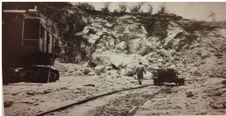
Explosión con dinamita en las montañas cercanas al campamento Las Flores, para la utilización de las rocas en los trabajos del Dique Boyacá y el Tajamar Occidental.
