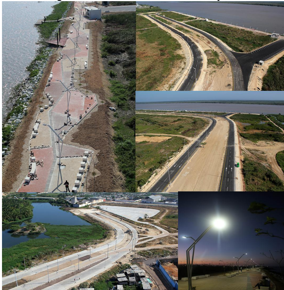
Fotografía 10. Avenida del Río 1.5km en ejecución
