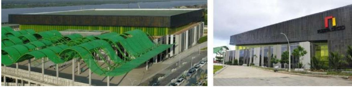
Figura 26. Centro de Eventos Puerta de Oro.
