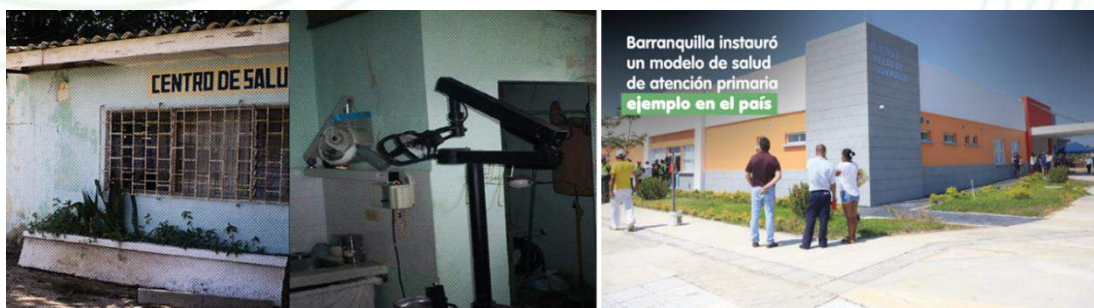
Ilustración 10. Puesto de salud antes y después de ser intervenido.
