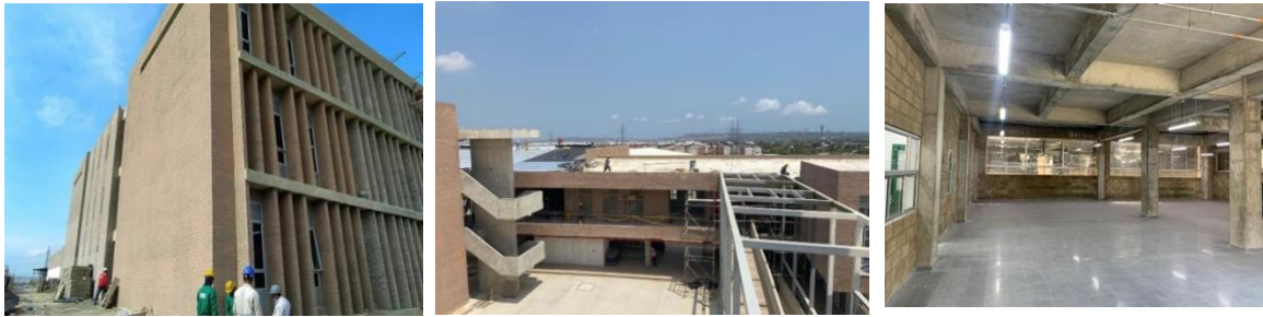
Mejoramiento en la Infraestructura de IEDs.
