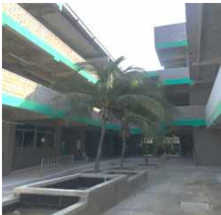
Reactivación de obra - IED Simón Bolívar
