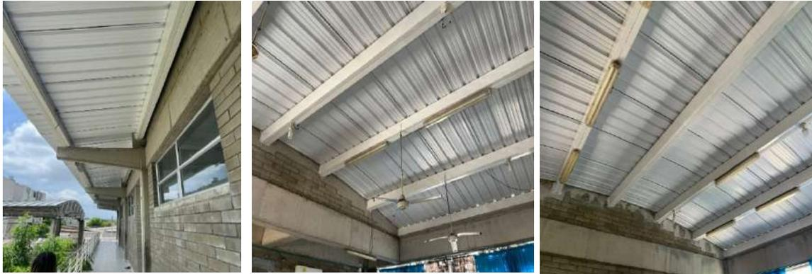
**IED.EL CAMPITO:** Mantenimiento general a la viga canal, construcción de pasante en muros con instalación de tuberías para drenar las aguas lluvias que se empozan en la escalera, curado, reparación de juntas de dilatación en 2 bloques. **AVANCE:** 100 % ejecutado.
