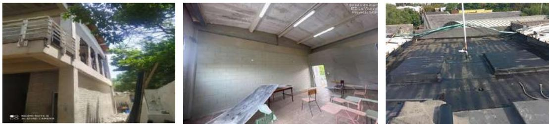
**IED. BARRIO SIMÓN BOLIVAR SEDE 1:** suministro e instalación de ventana corrediza, incluye cierre, vidrio transparente, rodajas, empaques, y accesorios. Demolición de enchape sobre muro de mampostería. Desmonte de aparatos sanitarios, suministro e instalación de aparatos sanitarios nuevos, mejoramiento general en baños. **AVANCE:** 100 % ejecutado.
