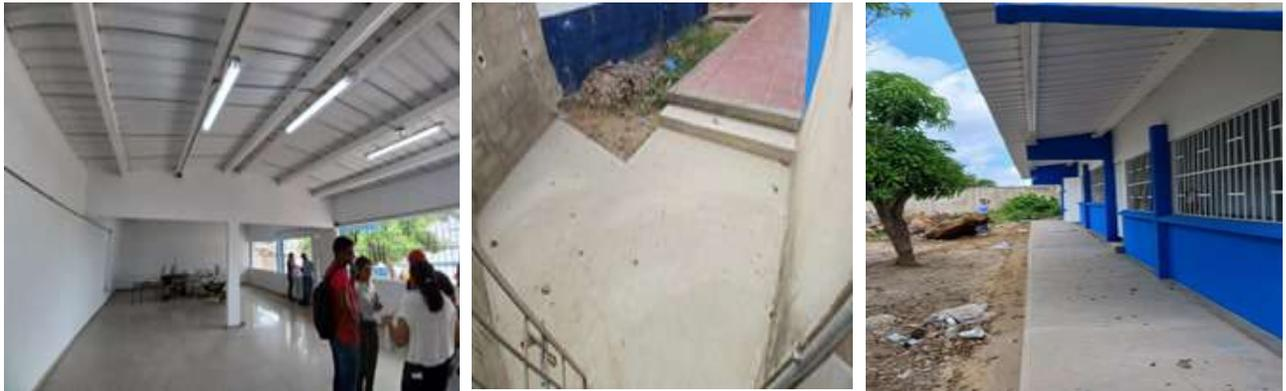
**IED DENNIS HERRERA DE VILLA:** **Alcance:** Cambio de estructura, cubierta del bloque plan alcalde, estructura de cubierta y reforzamiento de muro. **Avance:** 100 % ejecutado.
