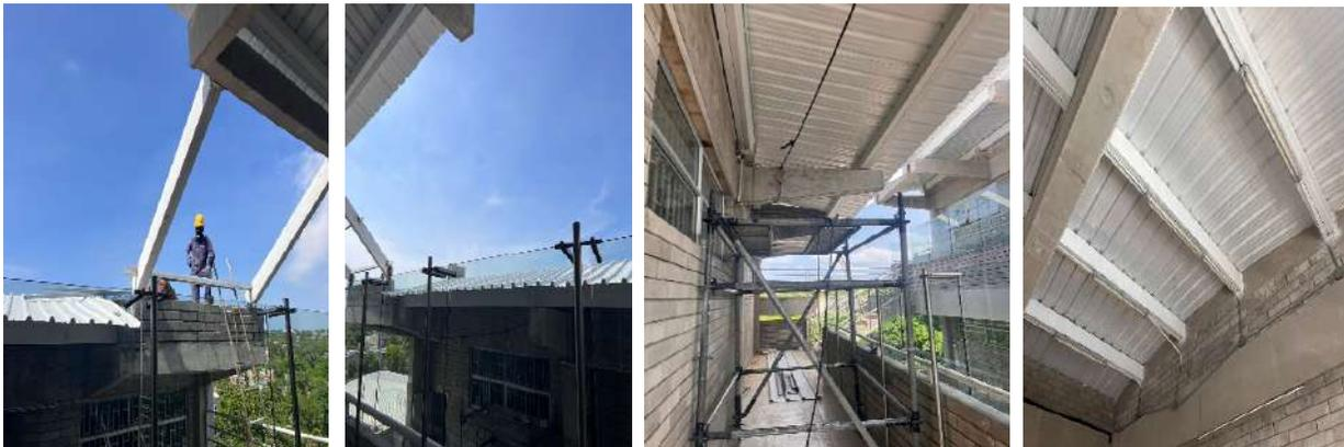
**IED.EL VALLE:** Demolición de tramo inclinado muro de cerramiento. Construcción de tramo de muro de cerramiento nuevo. Escarificación de pintura y pañete húmedo. Pañete exterior allanado con mortero impermeabilizado y pintura vinilo para exteriores. **AVANCE:** 90% en ejecución.
