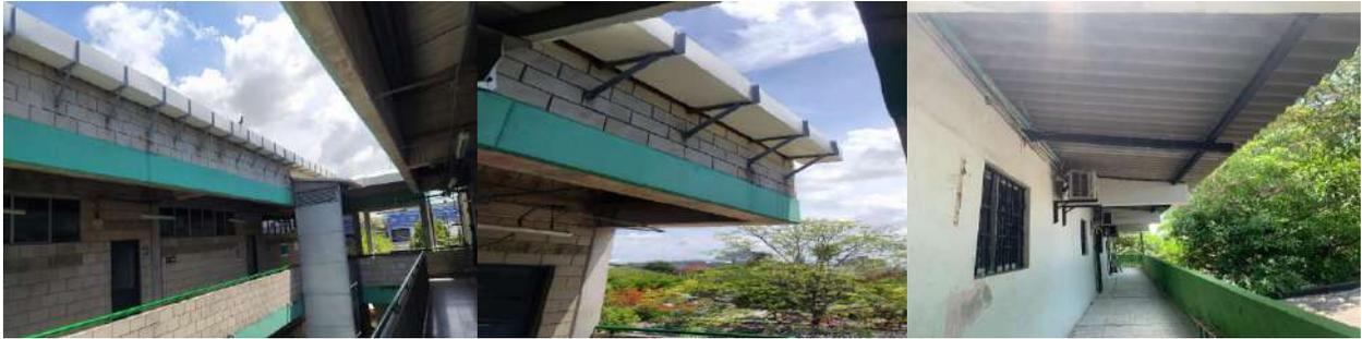
**IED. ALEJANDRO OBREGÓN:** suministro e instalación de canaleta lámina galvanizada para aguas lluvias desmonte de canaleta y retiro de material suministro e instalación de bajante de aguas lluvias. **AVANCE:** 100 % ejecutado.
