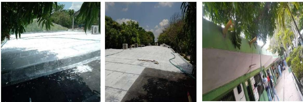
**IED. SAN SALVADOR SEDE 1:** Instalación de canaletas de aguas lluvias y bajantes, desmonte, suministro e instalación de cubierta en aulas colapsadas. **AVANCE:** 100 % ejecutado.
