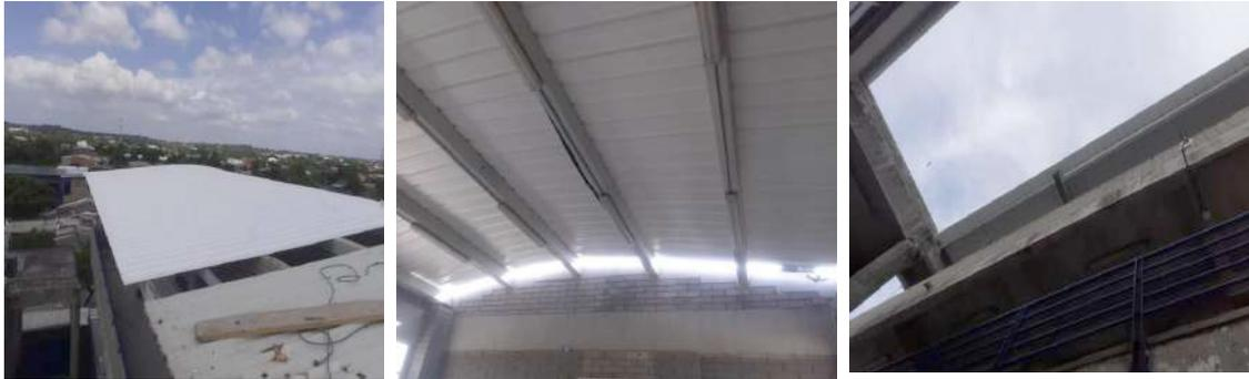
**IED. ROSALES SEDE 2:** Mantenimiento general de cubierta de los 2 bloques, impermeabilización de viga canal, suministro e instalación de ventanas, aplicación de hidrófugo en muros por filtraciones de aguas lluvias. **AVANCE:** 100 % ejecutado.
