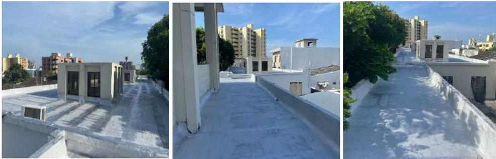
**IED.BUENOS AIRES:** Desmante de cubierta en mal estado, suministro e instalación de cubierta nueva, mantenimiento de estructura metálica de cubierta. **AVANCE:** 100 % ejecutado.
