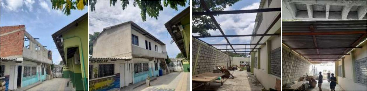
**IED. PARA EL DESARROLLO DEL TALENTO HUMANO (IDETH) SEDE 1:** impermeabilización de viga canal, con manto edil de cubiertas en aulas, desmonte suministro e instalación de canal tipo amazona, suministro e instalación de bajantes. **AVANCE:** 100 % ejecutado.
