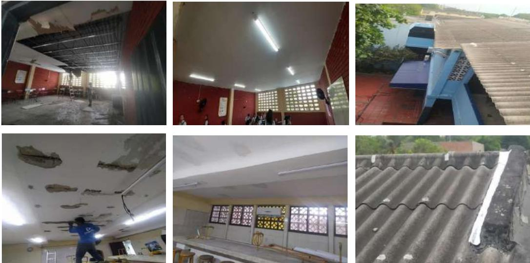
**IED JUAN MINA SEDE 2:** adecuaciones, reparaciones y mantenimiento de cielo raso y cubierta. Suministro de materiales para cubierta y cielo raso. **AVANCE:** 100% ejecutado y entregado.
