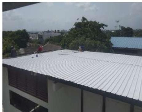
**IED.SONIA AHUMADA:** Cambio de cubierta en el bloque plan alcalde e impermeabilización de las losas.
