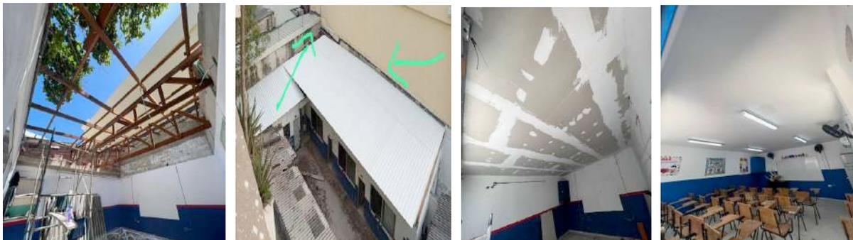
**IED. ROSALES SEDE 1:** Cambio de cubierta en mal estado en 3 aulas, suministro e instalación de cubierta en 3 aulas y mantenimiento a la estructura de la cubierta. **AVANCE:** 100 % ejecutado.
