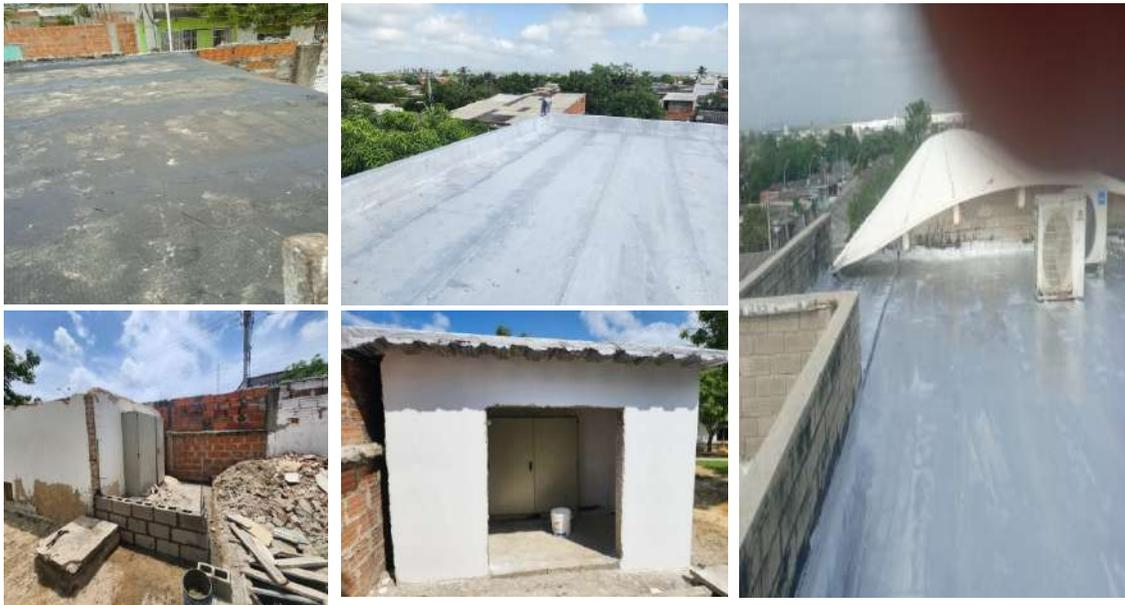
**IED.BETSABE ESPINOZA:** Mantenimiento general de puertas y ventanas en aulas de preescolar. Reemplazo de cubierta para 6 aulas, impermeabilización de muros de fachada con aplicación de hidrófugos en losas de circulación. **AVANCE:** 100 % ejecutado.
