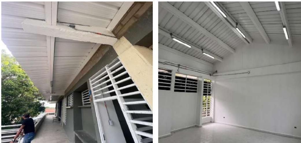
**IED CEB 161:** **Alcance:** Cambio de cubierta de aulas del bloque del primer piso, cambio de cubierta cancha múltiple y mantenimiento de estructura, acabados de aulas intervenidas, reemplazo de pisos en 3 aulas. **Avance:** 100 % ejecutado.
