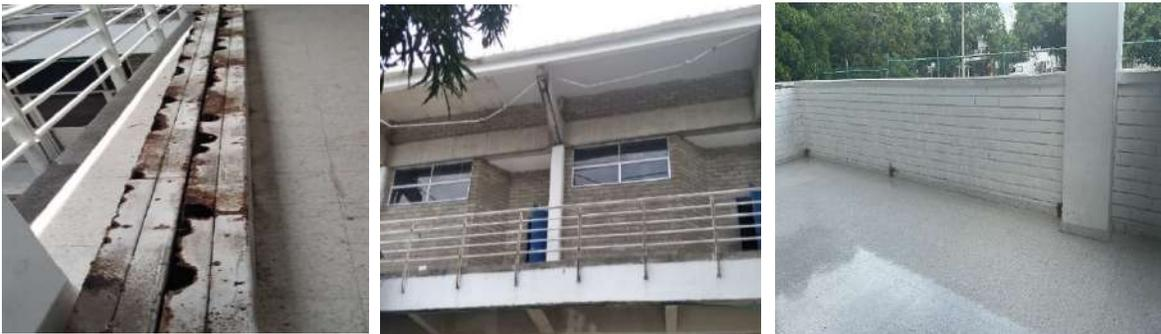
**IED. MARIA AUXILIADORA:** Retiro de manto viejo, reparcho de plantilla y nivelación, Impermeabilización con manto 3mm. **AVANCE:** 100 % ejecutado.
