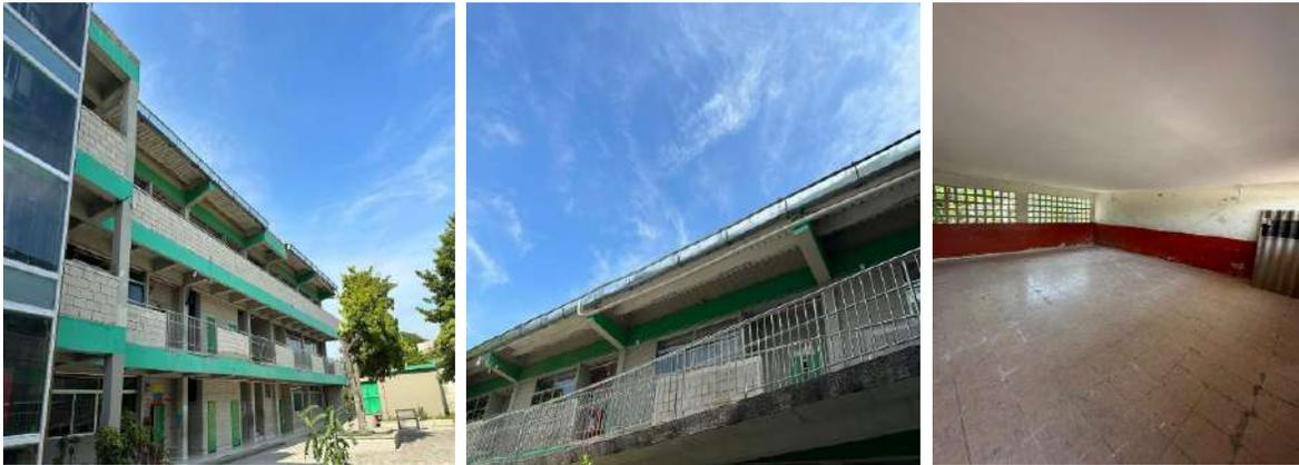
**IED.EVARDO TURIZO:** Cambio total de la cubierta del bloque Plan Alcalde, incluyendo los pasillos para paso entre bloque y bloque. Del mismo modo, se recomienda la limpieza con ácido nítrico, vanadox y aplicación de sika transparente o similar, para posteriormente aplicar hidrófugo para impermeabilizar. **AVANCE:** 90% en ejecución.
