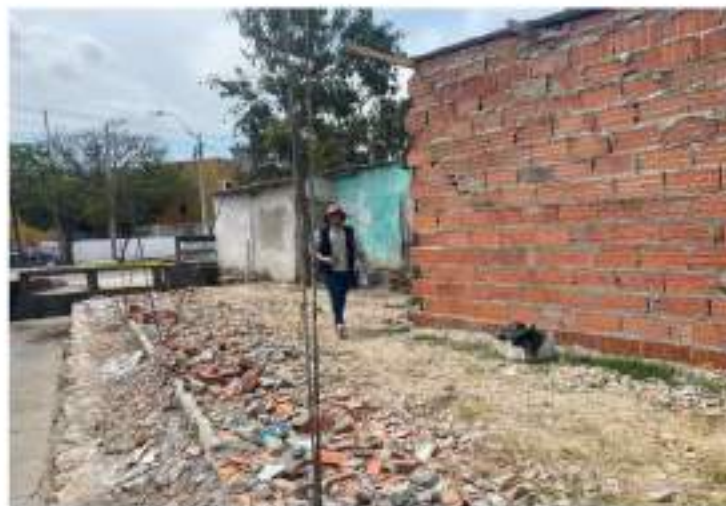
Apoyo a inspección por construcción en terreno
