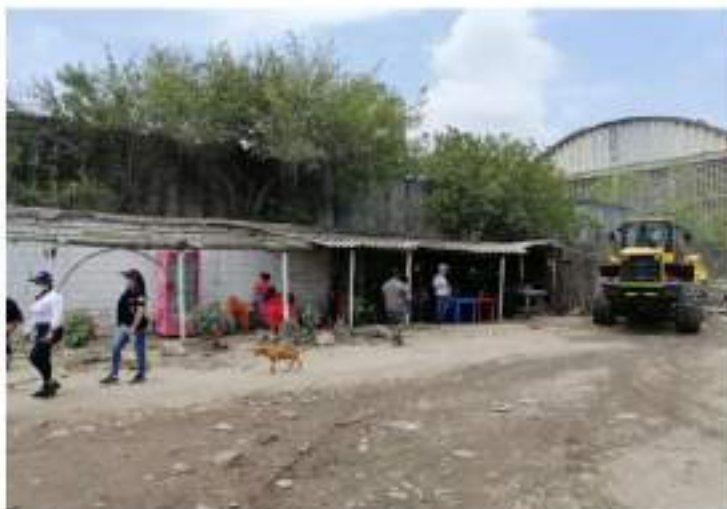
Recuperación de espacio público en la Cr 48*
