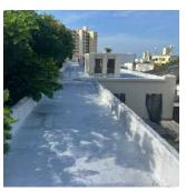
IED.BUENOS AIRES: Desmonte de cubierta en mal estado, suministro e instalación de cubierta nueva, mantenimiento de estructura metálica de cubierta. AVANCE: 100 % ejecutado.
