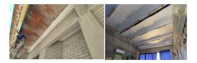
IED.SALVADOR SUAREZ SUAREZ SEDE 1: tiene calados q se les mete el agua lluvia a los salones del segundo piso y por ende se filtra por el plafón porque los pisos de arriba están en mal estado. AVANCE: 80% en ejecución.
