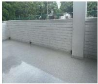
IED. MARIA AUXILIADORA: Retiro de manto viejo, reparcheo de plantilla y nivelación, Impermeabilización con manto 3mm. AVANCE: 100 % ejecutado.
