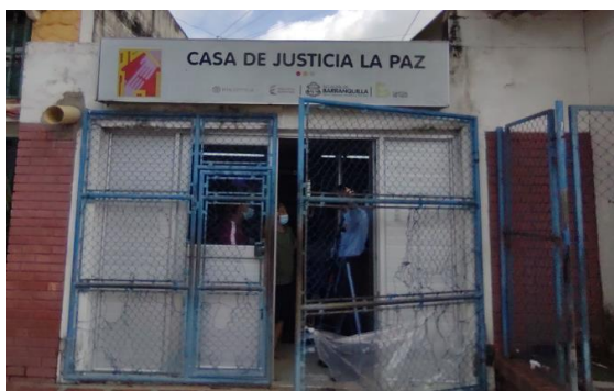
Foto 5. Fachada e ingreso en mal estado – Casa de Justicia la Paz
