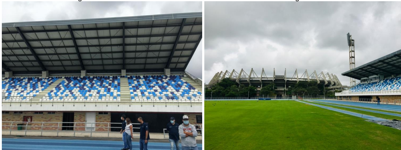
Fuente. Gerencia de Control Interno de Gestión - Registro Fotográfico Visita de Campo
