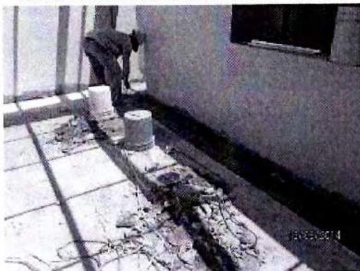
INSTALACIÓN DE PISO EN BALDOSA DE GRANITO Y APLICACIÓN DE ESTUCO SOBRE MURO (CDI LA ESMERALDA)
