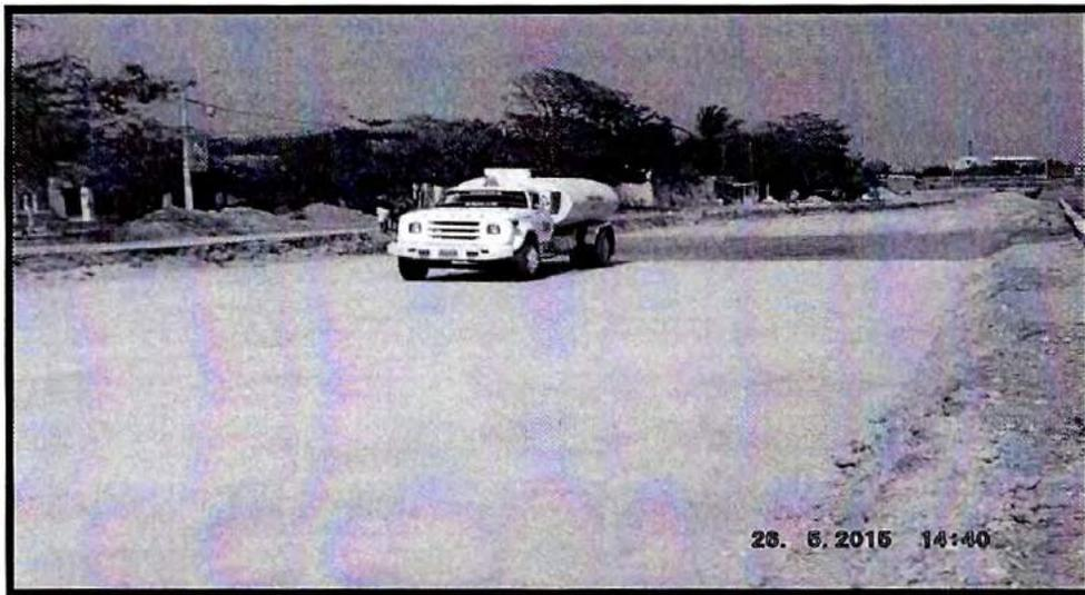
Imagen 1. Parque Bicentenario – Relleno de material seleccionado 1.10 m
