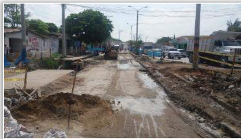
Foto 9. Construcción de canal de drenaje y reconstrucción delo pavimento en calzada norte de la Vía 40 sector Las Flores
