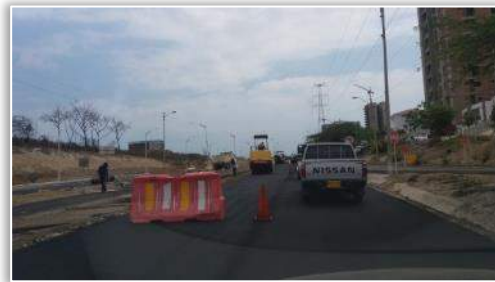
Foto 9. Construcción de canal de drenaje y reconstrucción delo pavimento en calzada norte de la Vía 40 sector Las Flores
