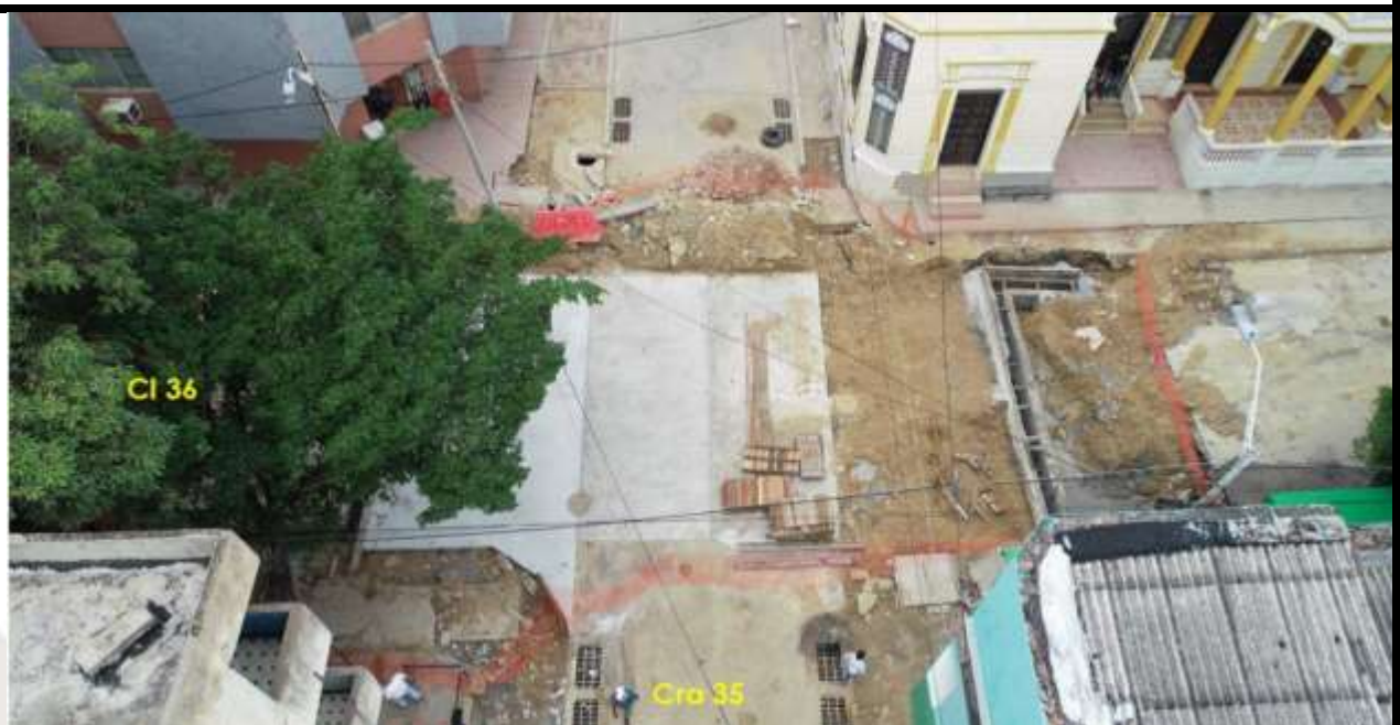
Adelanto de los trabajos de captacion de aguas lluvias sobre la calle 36 con carrera 35
