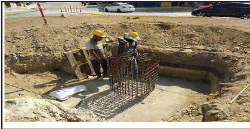
Construcción de pedestal para poste luminaria en rotonda 7 bocas
