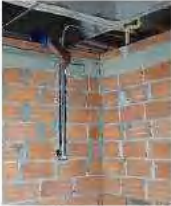
Avance red instalaciones eléctricas.
