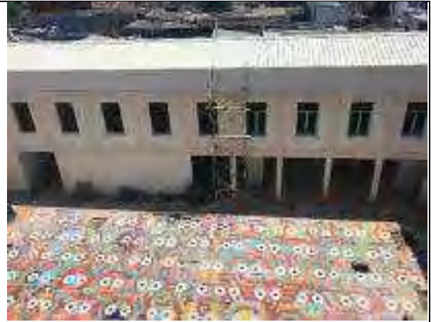
Instalación de enchape tipo pompeyano en plazoleta
