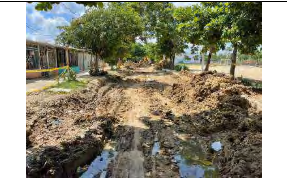
Calle 120 entre carrera 10 y 12. Barrio EL PUEBLO.
