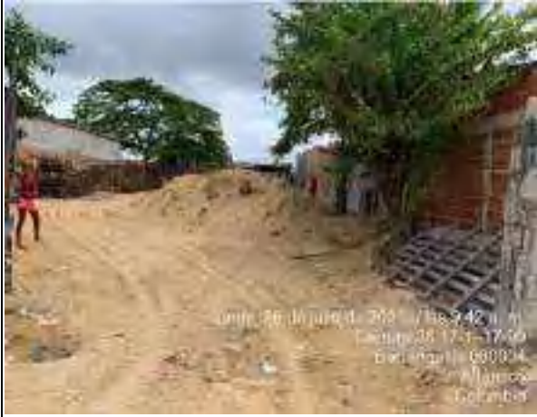
FOTO 3 RELLENO Y COMPACTACION EN PREDIO LOTE DE LOCALES
