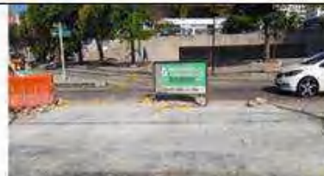
Acabado final de losa de pavimento en carrera 76 con calle 54 esquina
