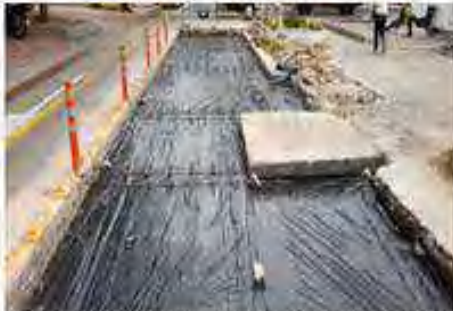
Preparación para instalación de concreto m45 en calle 80 entre carrera 43b y 44
