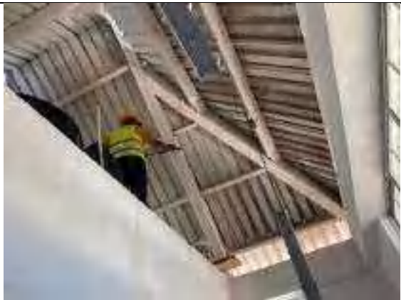
Instalación de cielo raso en pvc
