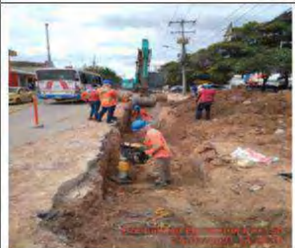
construcción de bordillo, sumideros, registros, excavación para tuberías y banco de ductos, reparación de placas fisuradas y corte y sellado de juntas.
