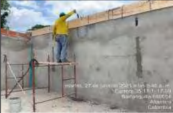
FOTO 5 FUNDIDA DE VIGA AEREA EN PREDIO DE LA CR 35 #17-80
