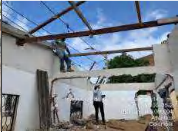
FOTO 4 DESMONTE DE CUBIERTA EXISTENTE EN PREDIO DE LA CALLE 11 #35-07
