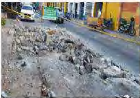
Demolición de pavimento en la calle 32 entre carrera 45a y 45
