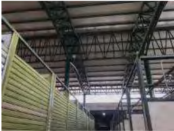
Estructura metalica de la cubierta
