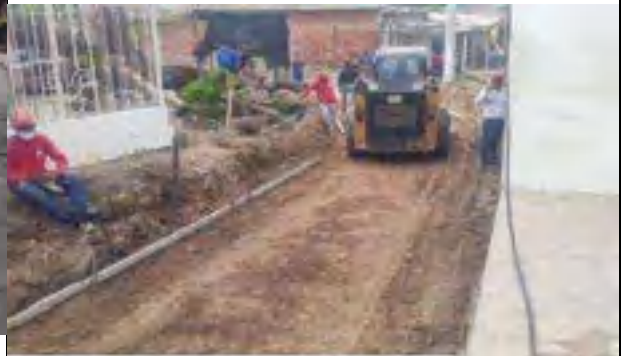
ilustración 8. Excavación a máquina en calle 17c entre 6c y 7ª
