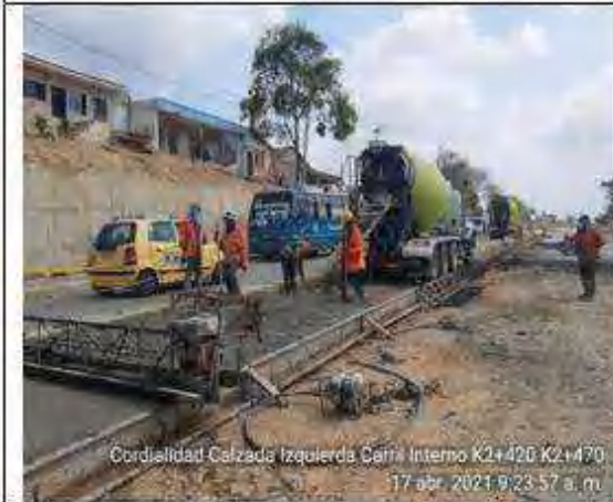
excavación, extendido de suelo cemento, imprimación, armado de rieles y fundida de placas de concreto, construcción de muros de contención.
