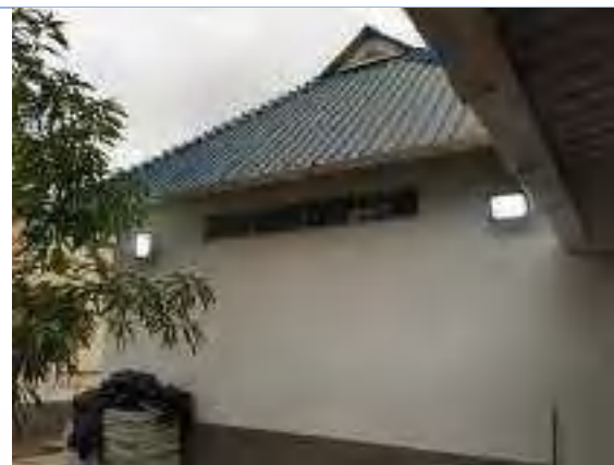
Instalación de reflectores led
