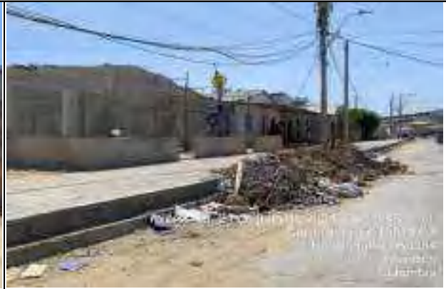
FOTO 2 ALINEAMIENTO PARA FUNDIDA DE VIGA AEREA DE PREDIO DE LA CR35 #17-80
