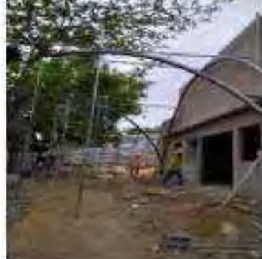
Avance montaje estructura metálica marquesina entrada emergencia.
