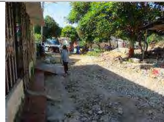
Diagnóstico Tramo Las Américas Carrera 3D entre Calle 51C – Calle 52B
