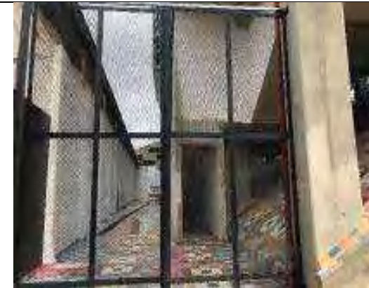
Instalación de portón de cerramiento Calle 40
