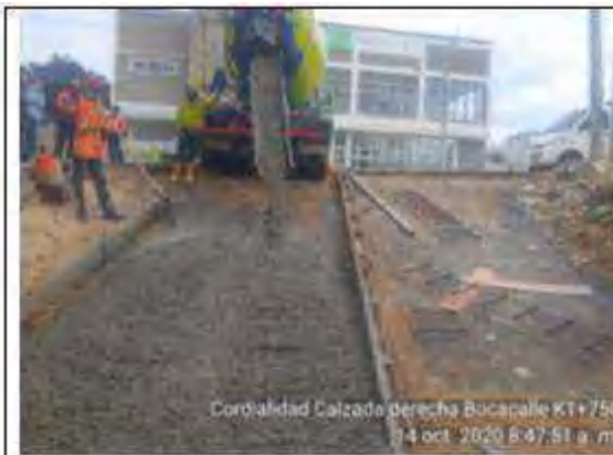
Fundida de pavimento en concreto.
