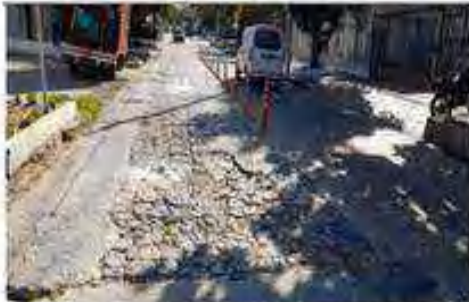
Estado inicial de la calle 80 entre carrera 43b y 44
