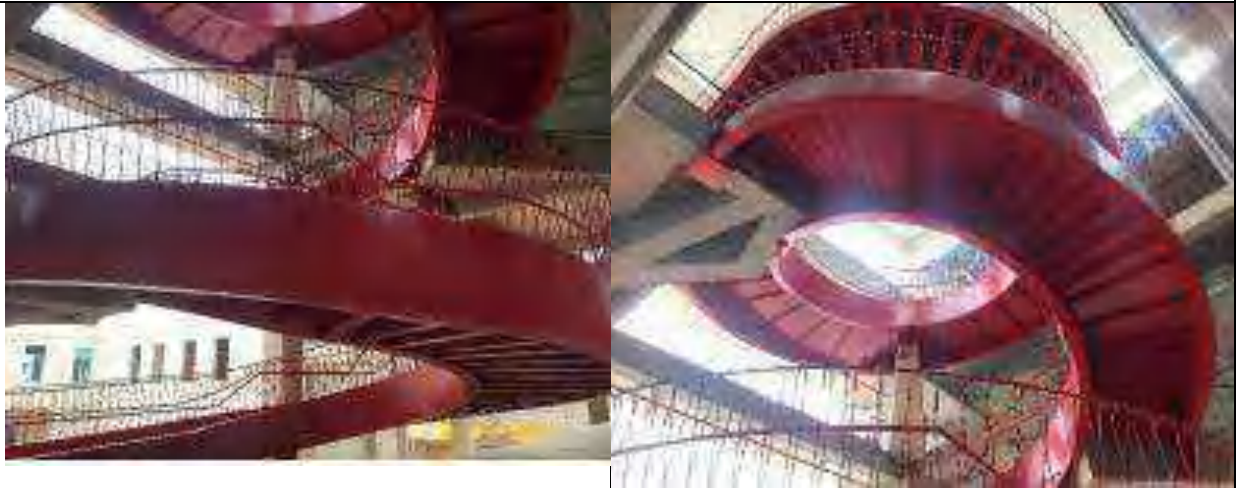
Escalera metálica terminada de instalar
