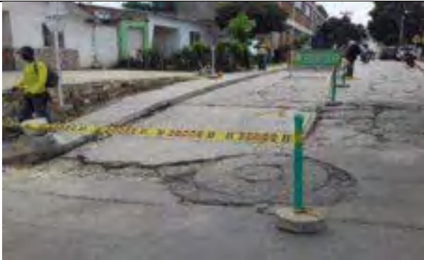
ilustración 5. Instalación de concreto mr35 en calle 17c entre 6c y 7a
