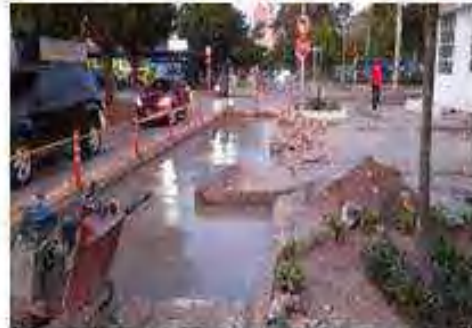
Instalación de concreto fluido en calle 80 entre carrera 43b y 44
