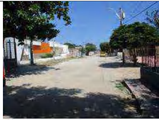
Diagnóstico Tramo Rebolo Calle 15 entre Carrera 28 – Carrera 30
