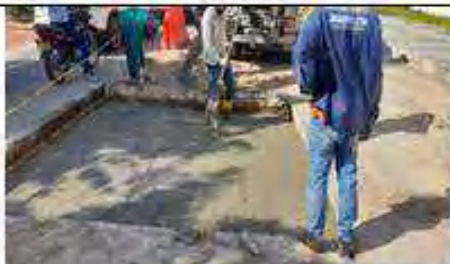
instalación de concreto fluido en calle 76 en carrera 60 y 59.
