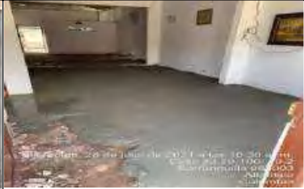
FOTO 6 CONSTRUCCION DE PLANTILLA DE NIVELACION PISOS LUZ MARINA.
