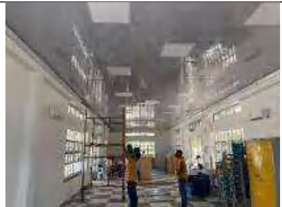
Instalación de cielo raso en pvc
