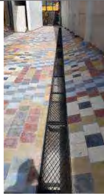
Instalación de rejillas en canales de aguas lluvias
