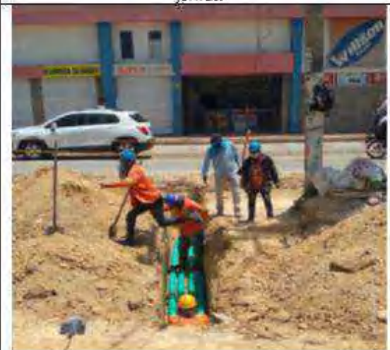
construcción de bordillo, sumideros, registros, excavación para tuberías y banco de ductos, reparación de placas fisuradas y corte y sellado de juntas.
