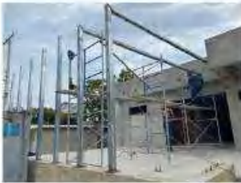
Avance montaje estructura metálica entrada ambulancias.
