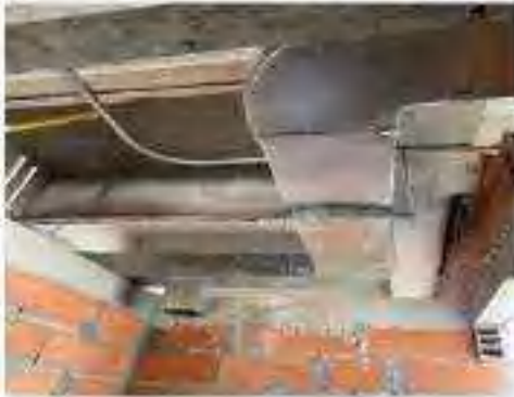
Avance red de extracción mecánica.
