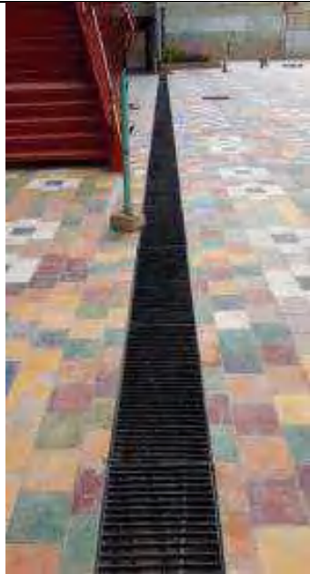
Instalación de rejillas en canales de aguas lluvias
