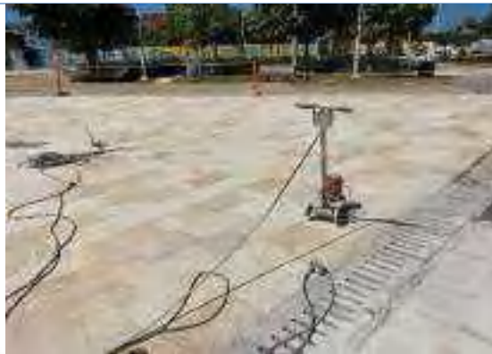
Pulida de pisos exteriores
