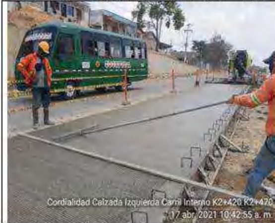
excavación, extendido de suelo cemento, imprimación, armado de rieles y fundida de placas de concreto, construcción de muros de contención.
