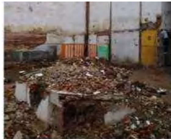
Demolición de mampostería en concreto
