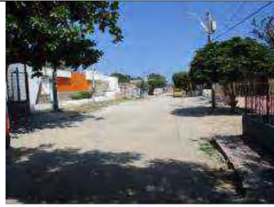
Diagnóstico Tramo Rebolo Calle 15 entre Carrera 28 – Carrera 30
