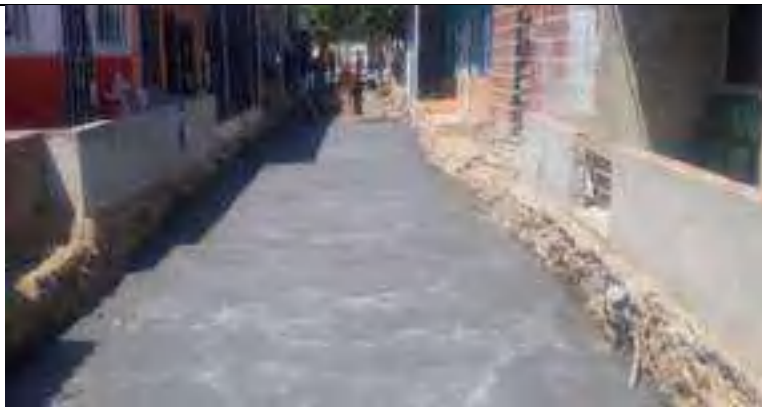
Concreto Fluido 1500psi en la carrera 22ª entre calle 83B y 84 barrio El Porfin.
