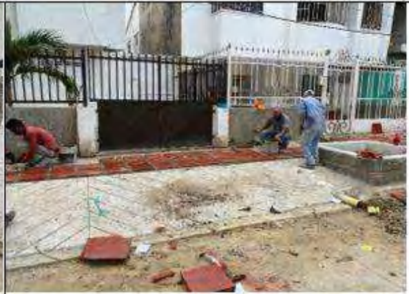
Reposición de espacio público en la calle 40B con carrera 17
