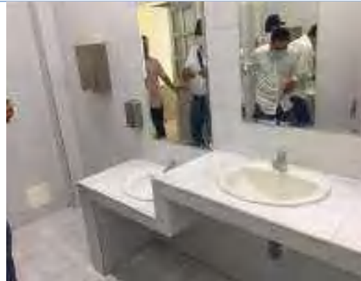
Cambio de lavamanos
