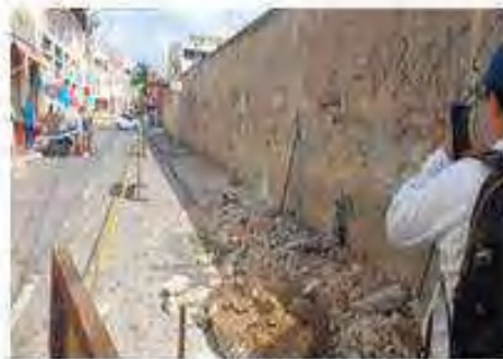
Demolición de andén en la calle 32 entre carrera 44 y 43
