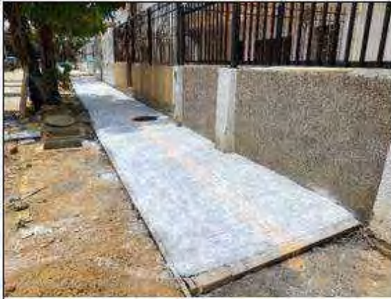
Concreto estampado fundido en la carrera 17 con calle 40
