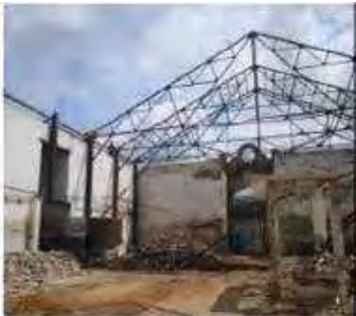
Desmonte de cerchas
