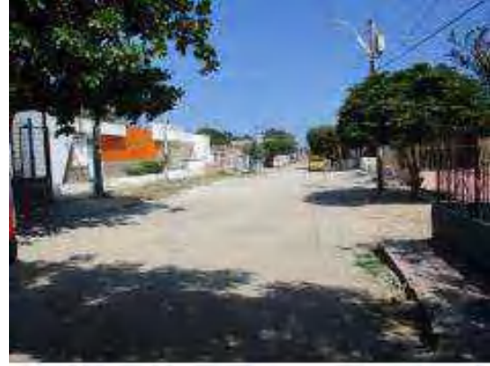
Diagnóstico Tramo Rebolo Calle 15 entre Carrera 28 – Carrera 30
