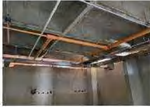
Avance red de extracción mecánica.
