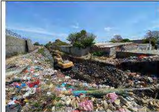
Limpieza de sedimentación en arroyo bajo el puente Santo Domingo, calle 88
