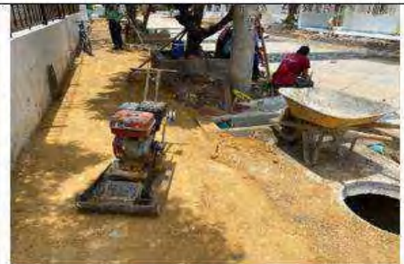
Compactación de terreno para acabado de espacio público
