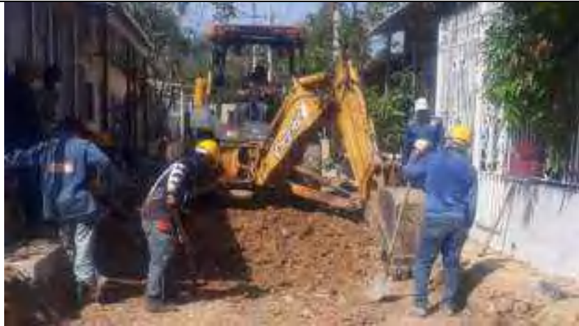
Excavación carrera 21F con calle 83B en barrio el Porfin.
