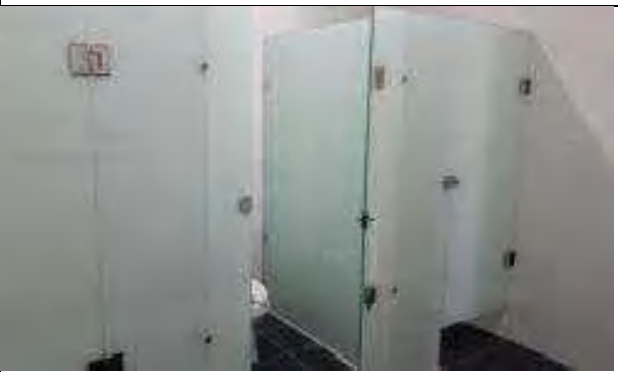
Instalación de divisiones de baño de mujeres
