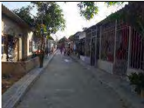
Acabado final de pavimento y urbanismo en barrio Por fin Carrera 21F entre 83b y 84
