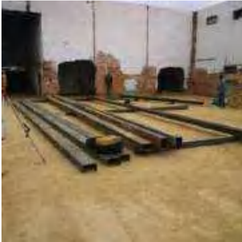
Soldadura de Estructura de Cercha
