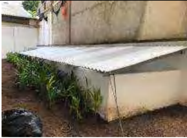
Instalación de cubierta translúcida
