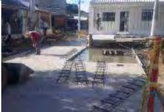
ilustración 5. Instalación de concreto mr35 en calle 17c entre 6c y 7a
