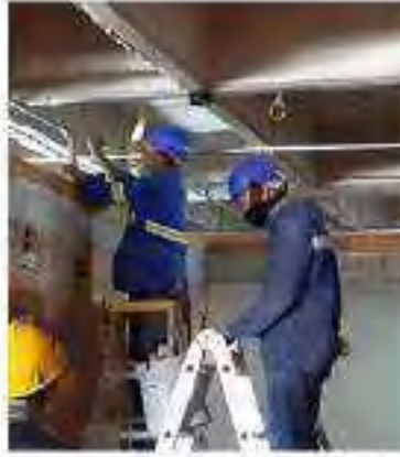
Avance red instalaciones eléctricas.
