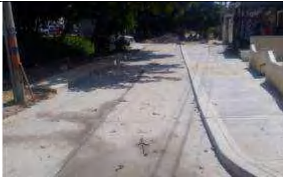
ilustración 1. Acabado final de pavimento, bordillo y andenes de la carrera 7A entre 17B y 17C
