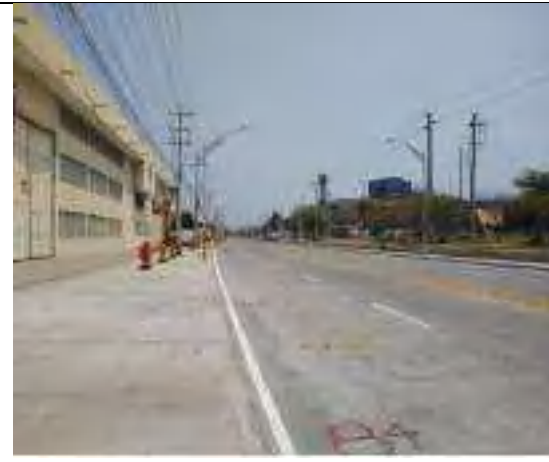
MEJORAMIENTO Y/O PAVIMENTACIÓN DE LA VÍA 40 ENTRE CALLE 85 Y CALLE 110 Y MODERNIZACIÓN DEL ALUMBRADO PÚBLICO EN EL DISTRITO DE BARRANQUILLA.
