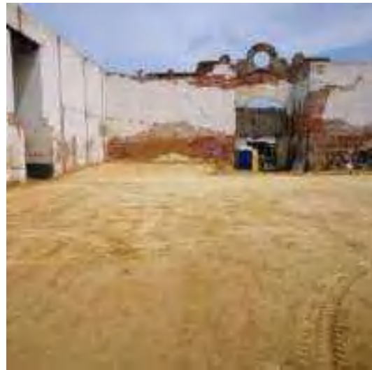
Sellado de relleno (altura: 1.1 m)
