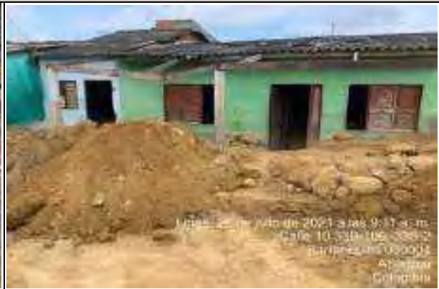
FOTO 2 RELLENO EN PREDIO DE LA CALLE 10 #33B - 202
