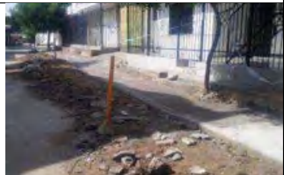
ilustración 4. Instalación de bordillo y andén en la calle 27 con carrera 3C
