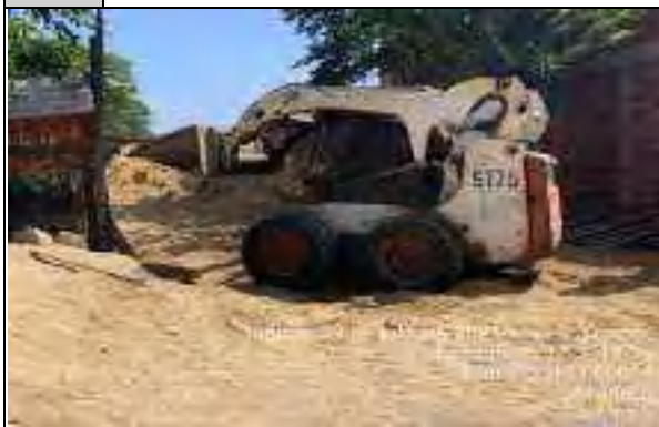
FOTO 5 RELLENO Y COMPACTACION EN PREDIO PATIO DE LOCALES DE LA 17
