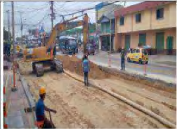
demolición, excavación, conformación, vibrado, imprimado, fundido y acabado de pavimento.
