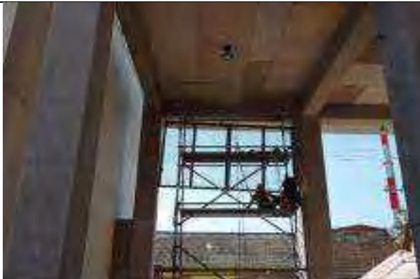
Instalación de cerramiento Calle 40
