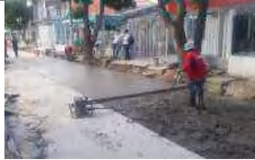
ilustración 6. Instalación de concreto mr35 en calle 17c entre 6c y 7a
