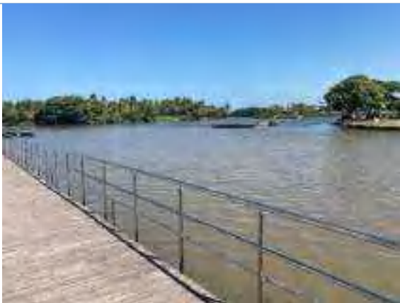
Instalación y pintura baranda galvanizada
