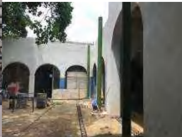
cimentacion y estructura de cubierta
