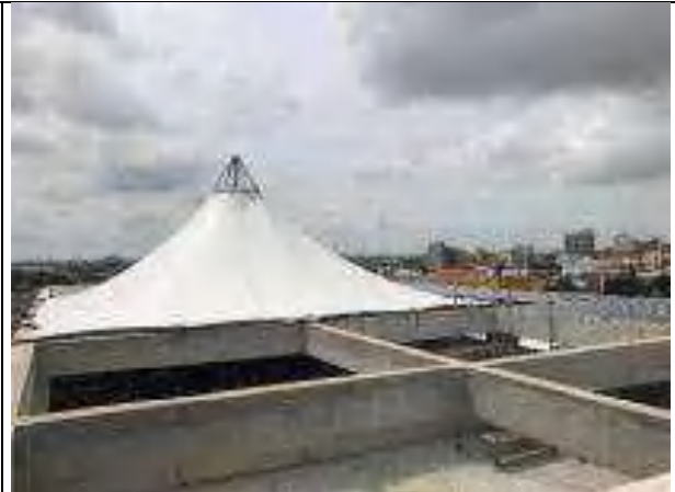
Cerramiento con lona eje central del edificio
