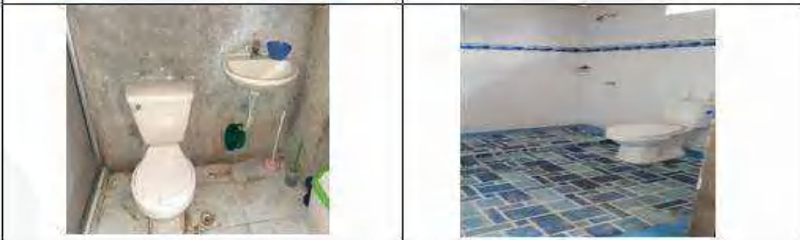
Obras de mejoramiento en baño, cocina y sala. Dirección: K 67 # 73- 17
