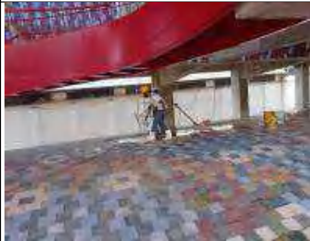
Limpieza y pulida de enchape pompeyano sobre cúpula
