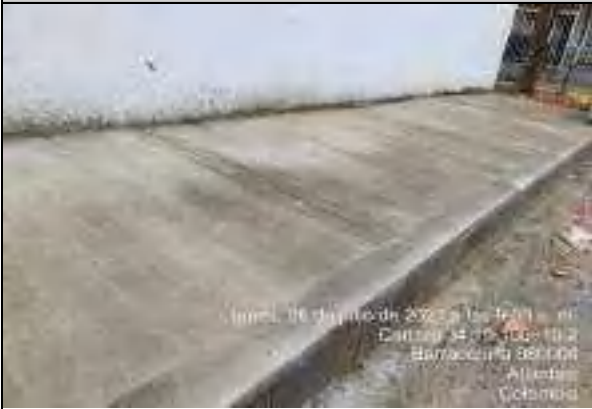
FOTO 1 FUNDIDA DE ANDENES EN LA CR35 ENTRE CALLES 10 A 11
