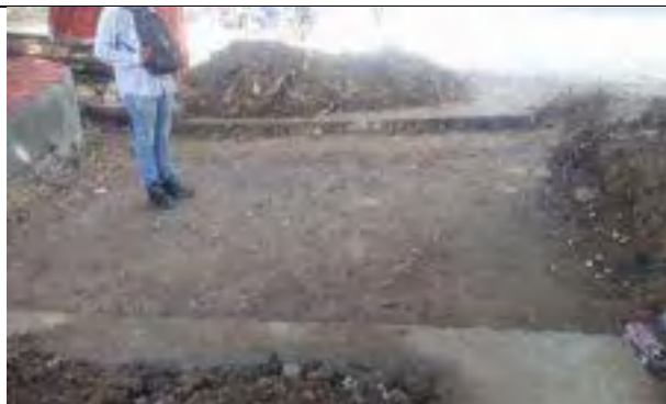
ilustración 3. Preparación para instalación de concreto MR35 en calle 27 con carrera 3C
