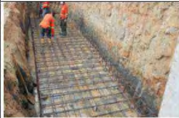
Acero de refuerzo figurado
