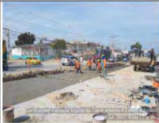
demolición, excavación, conformación, vibrado, imprimado, fundido y acabado de pavimento.
