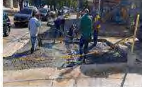
Instalación de concreto m45 en la calle 79 con carrera 49b
