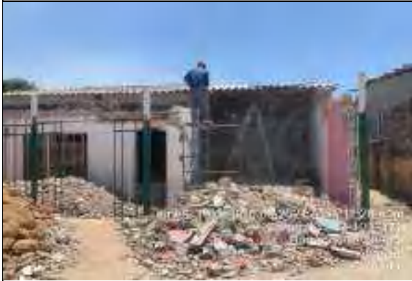
FOTO 1 DEMOLICION DE LOSA SUPERIOR O PLAFON DEL PREDIO DE LA CR35 #17-110
