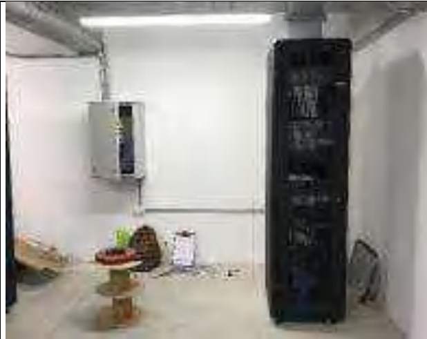
Instalación y armado de rack de telecomunicaciones
