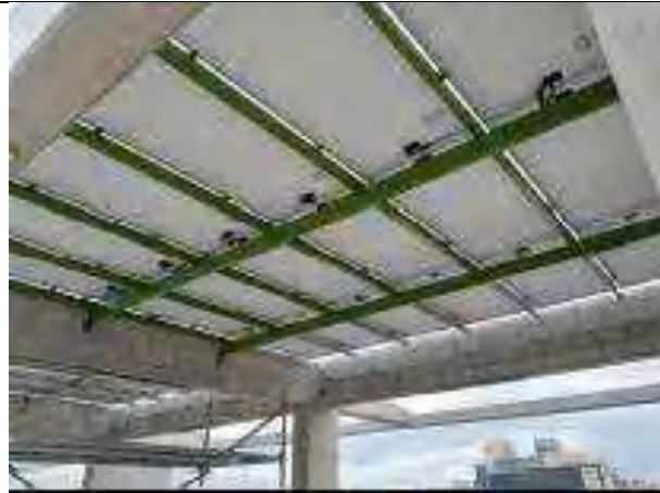
Detalles pintura estructura paneles solares
