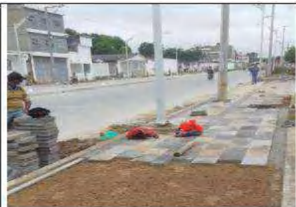
Instalación de loseta peatonal en espacio público.
