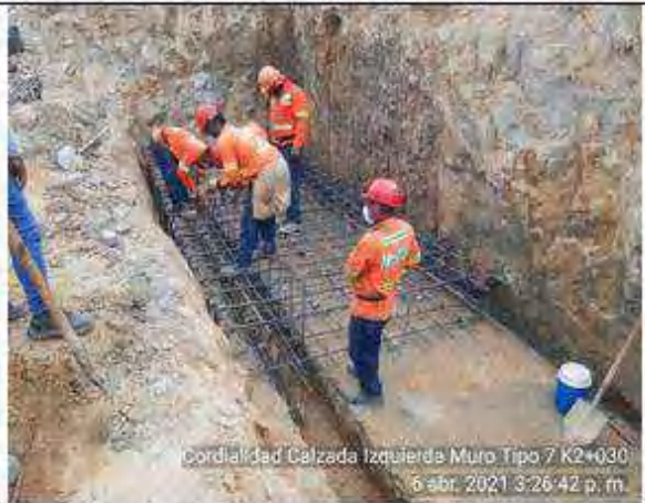
excavación, extendido de suelo cemento, imprimación, armado de rieles y fundida de placas de concreto.
