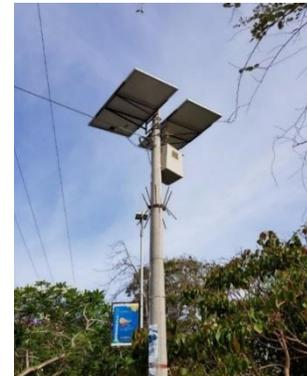
Ilustración 4 Sistema de energía solar para funcionamiento
