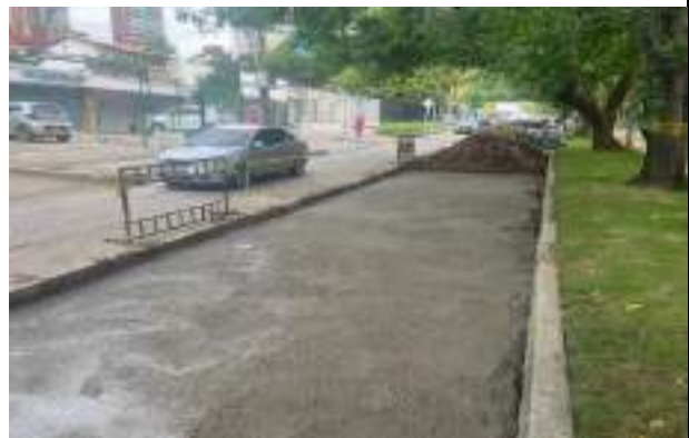
Imagen 24. Base en concreto fluido. Calle 79 con carrera 59.
