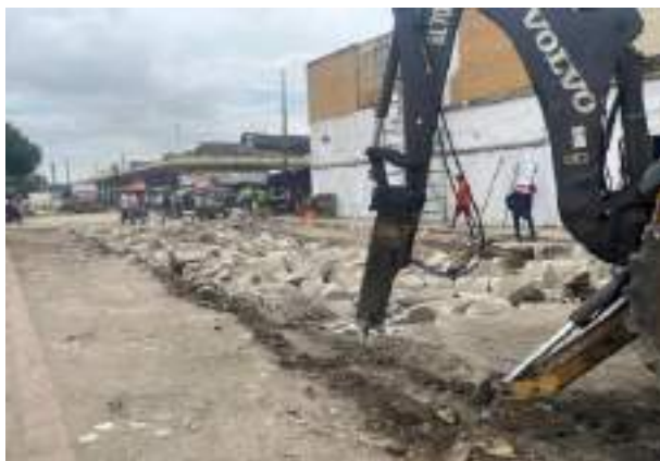
Imagen 15. Demolición de pavimento existente. Calle 10 entre Carrera 41B y 41B, Barranquillita.
