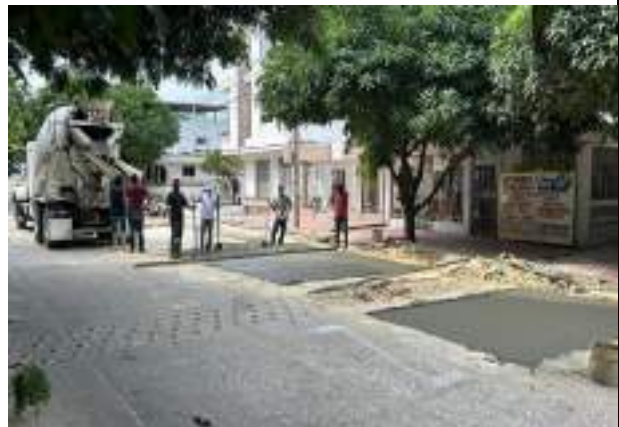
Imagen 20. Pavimento en concreto rígido. Calle 36B entre carrera 8 y 6B.
