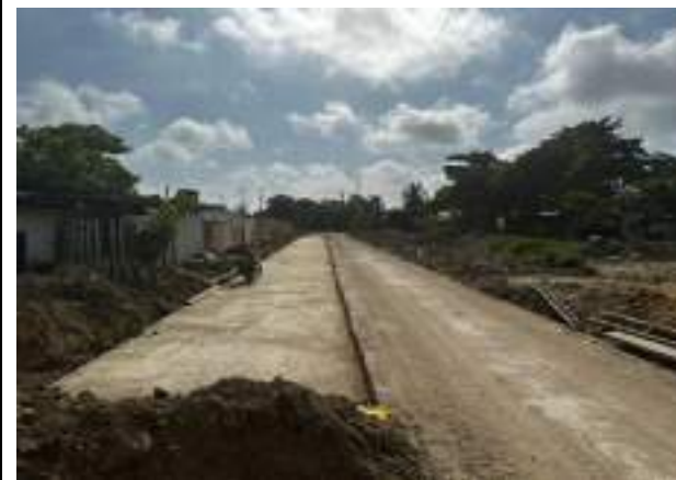
Imagen 7. vaciado de concreto solado para estructura de pavimento bendición de Dios.
