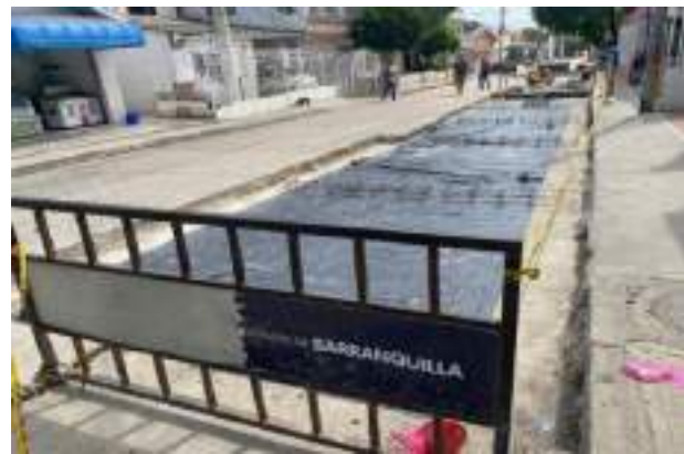
Imagen 14. demolición y reparación de losas por garantía.
