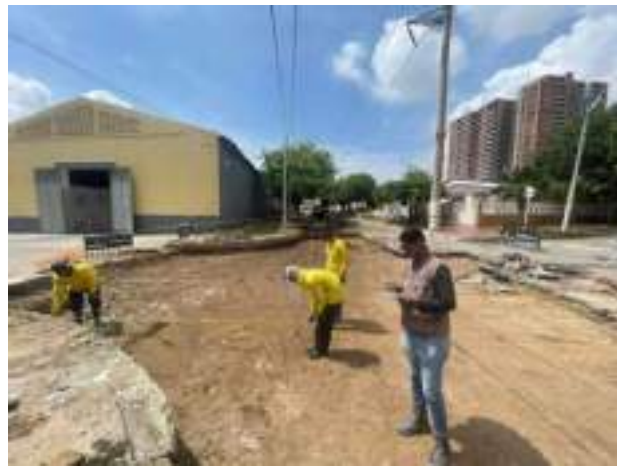
Imagen 28. nivelación de subrasante calle 69 con carrera 68.
