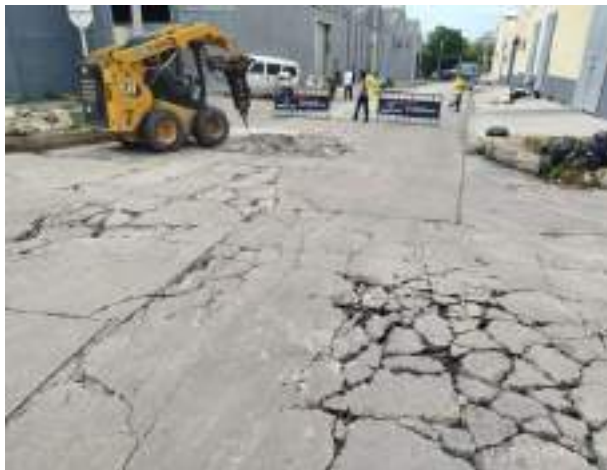
Imagen 27. demolición de pavimento existente calle 69 con carrera 68.
