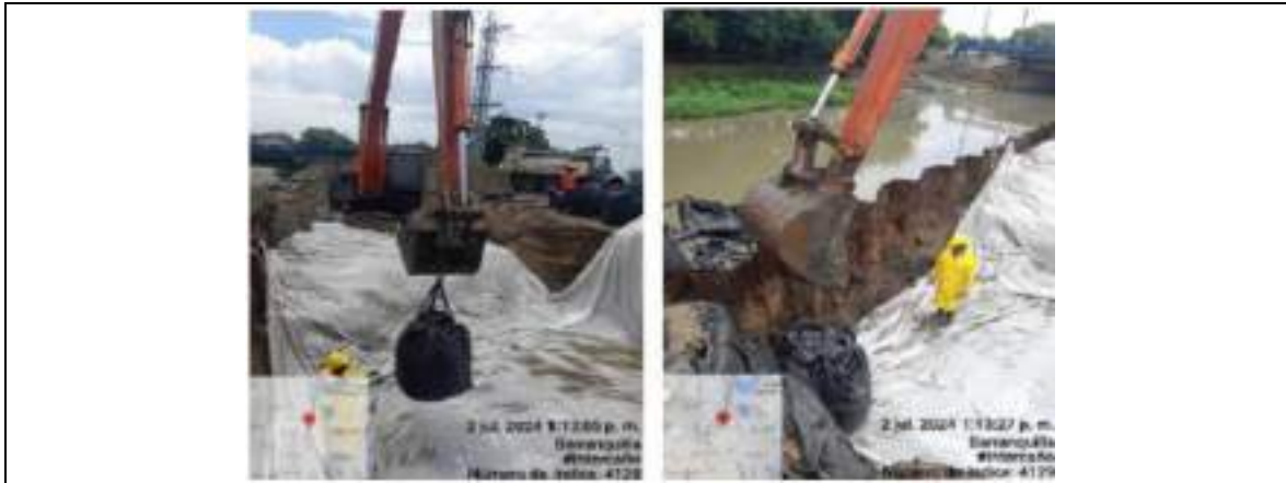
Instalación de Geobags K2+412 -K2+419
