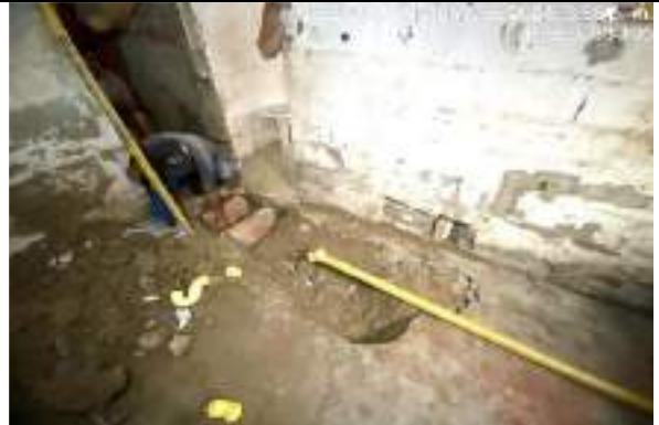
Ilustración 6. Adecuación de redes hidrosanitarias - Postulante Yaneth Padilla - Barrio Las Malvinas
