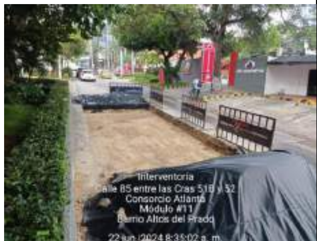
Imagen 32. nivelación de subrasante calle 85 entre las cra 51by 52.
