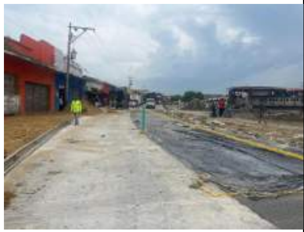
Imagen 18. Pavimento en concreto rígido. Calle 10 entre Carrera 41 y 41B, Barranquillita.
