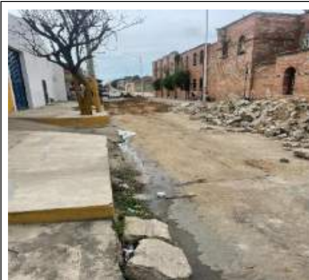
Imagen 1. Demolición de pavimento calle 35 entre carrera 35 y 34.
