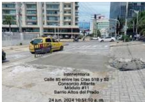
Imagen 34. vaciado concreto mr para estructura de pavimento calle 85 entre 51B y 52.
