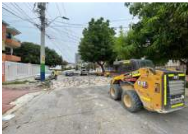
Imagen 33. demolición de pavimento existente carrera 66 entre 58 y 64.
