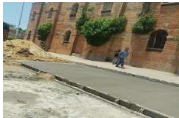
Imagen 4. Pavimento en concreto rígido. Calle 35 entre carreras 35 y 34.
