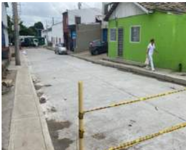
Imagen 11. vaciado de concreto mr para estructura de pavimento calle 85 entre 81 y vía 40.
