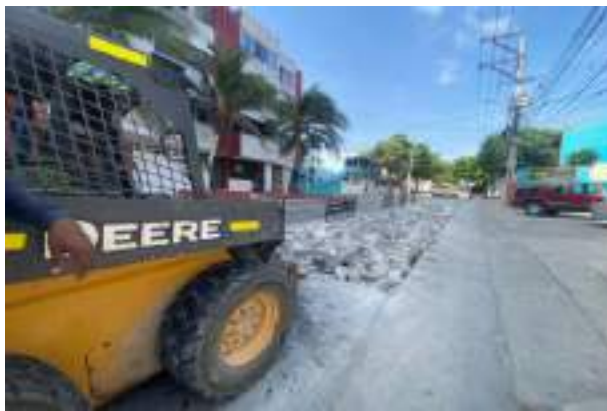
Imagen 13. demolición y reparación de losas por garantía.
