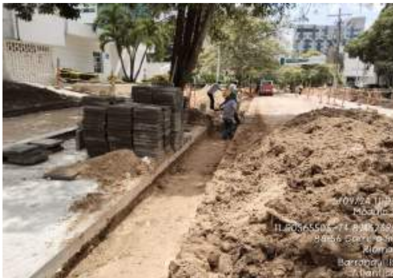
Frente de Trabajo Carrera 50 calle 87 – 86 – Excavación manual - ampliación de pavimento (costado derecho)
