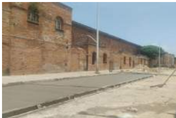
Imagen 3. Pavimento en concreto rígido. Calle 35 entre carreras 35 y 34.
