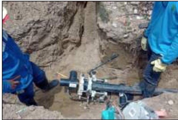
Frente de Trabajo Barrio La Playa Calle 16
