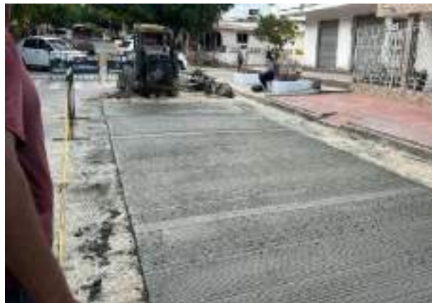
Imagen 19. Pavimento en concreto rígido. Calle 36B entre carrera 8 y 6B.
