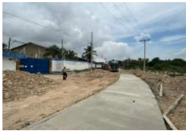
Imagen 8. vaciado de concreto solado para estructura de pavimento bendición de Dios.
