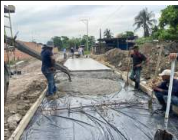
Imagen 5. vaciado de concreto MR para estructura de pavimento bendición de Dios
