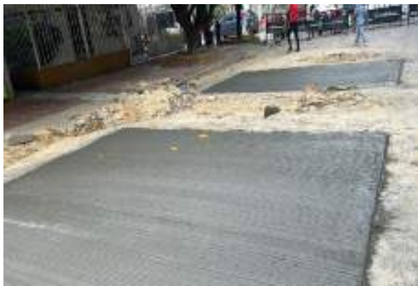
Imagen 21. Pavimento en concreto rígido. Calle 36B entre carrera 8 y 6B.
