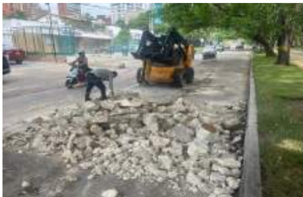
Imagen 23. Demolición de pavimento existente. Calle 79 con carrera 59.
