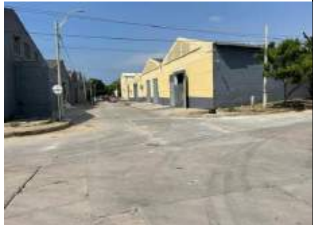
Imagen 30. vaciado concreto mr para estructura de pavimento calle 69 con carrera 68.
