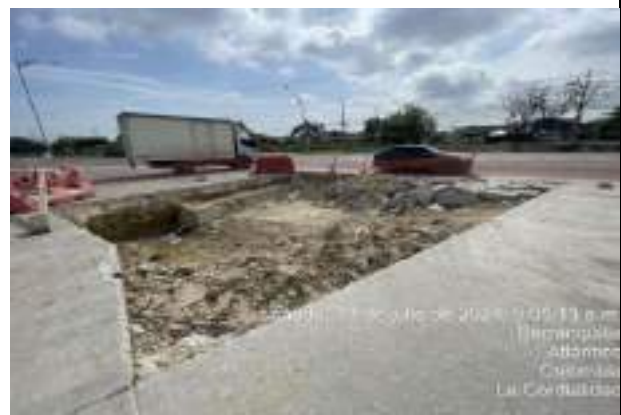
Imagen 10. demolición de losa existente box culbert metro parque.
