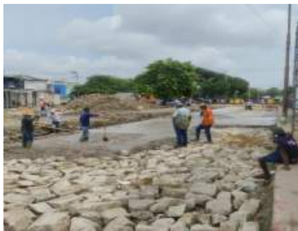
Imagen 17 Relleno compactado en piedra cimiento para estabilización. Calle 10 entre Carrera 41 y 431B, Barranquillita.
