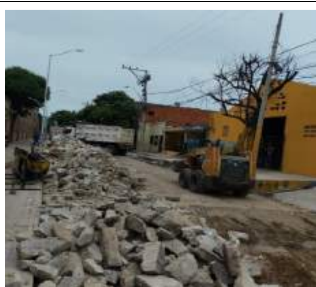
Imagen 2. Relleno de material. calle 35 entre carrera 35 y 34. -
