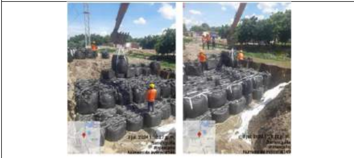
Instalación de Geobags K2+417 - K2+420
