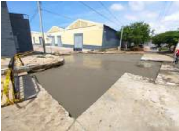
Imagen 29. concreto solado para estructura de pavimento Calle 69 con carrera 68.
