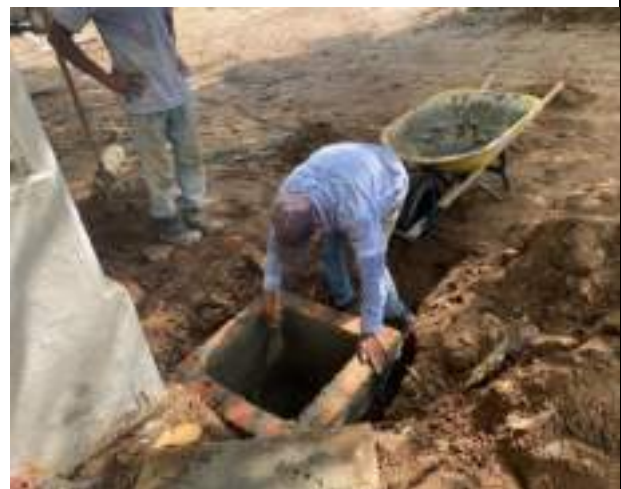
Imagen 12. reconstrucción de registros alcantarillado cra 80 entre las calles 85 y 86.
