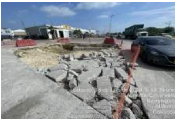
Imagen 9. demolición de losa existente box culbert metro parque.
