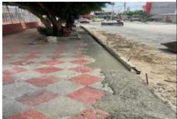
Imagen 22. Reparación de terraza. Calle 36B entre carrera 8 y 6B.
