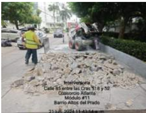
Imagen 31. demolición de pavimento existente calle 85 entre carreras 51B y 52.
