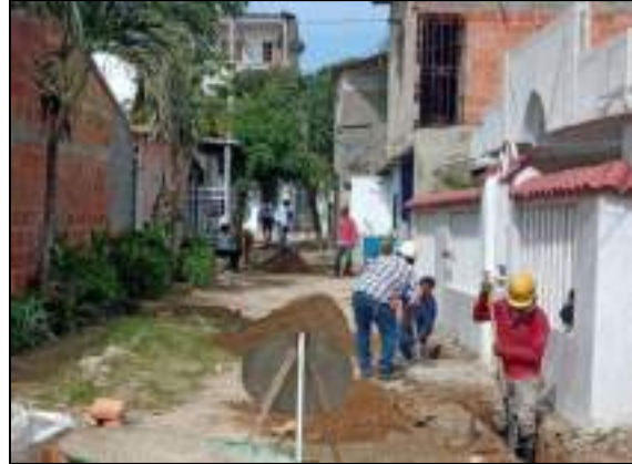
Frente de Trabajo Barrio La Playa Calle 18
