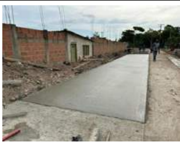
Imagen 6. vaciado de concreto MR para estructura de pavimento bendición de Dios
