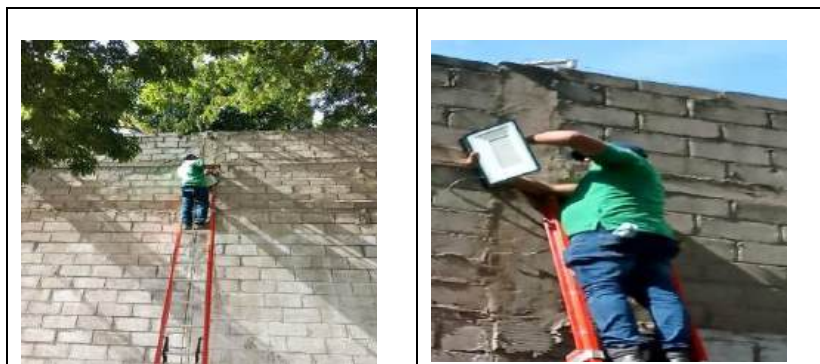
Pintura General y cambio de lamparas Secretaria de transito calle 30
