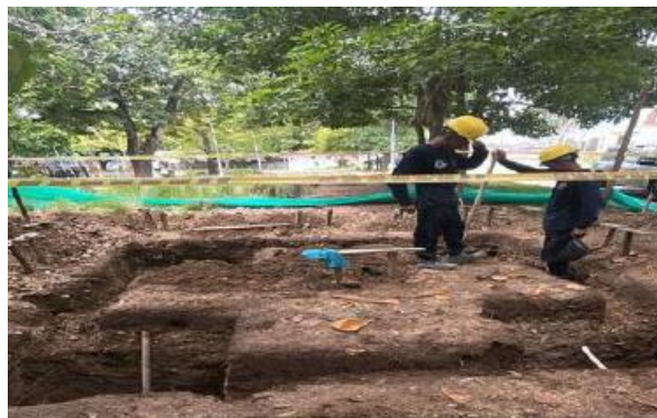
Excavación manual para zapatas de cimentación en la estación de taxis Riomar
