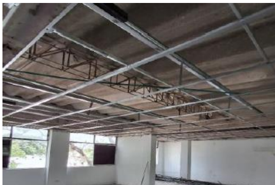
Demolición de cielo raso existente en Escuela de policía Antonio Nariño_Calle 17
