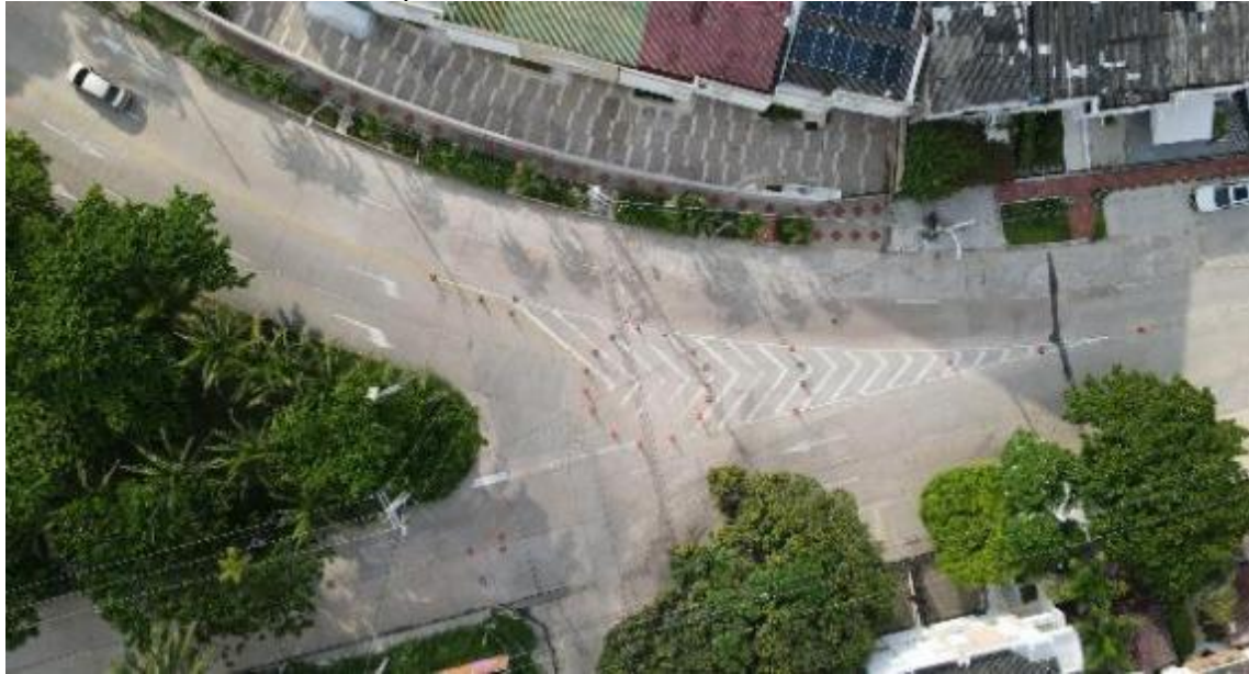
Ilustración 37. Glorieta implementada durante laboratorio en la Cra. 49C con CL 98
