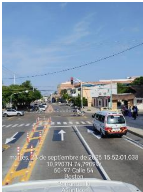
Ilustración 40. Implementación de nuevos resguardos peatonales y mantenimiento de los existentes
