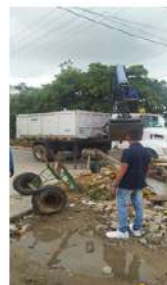
Destrucción de carretas
