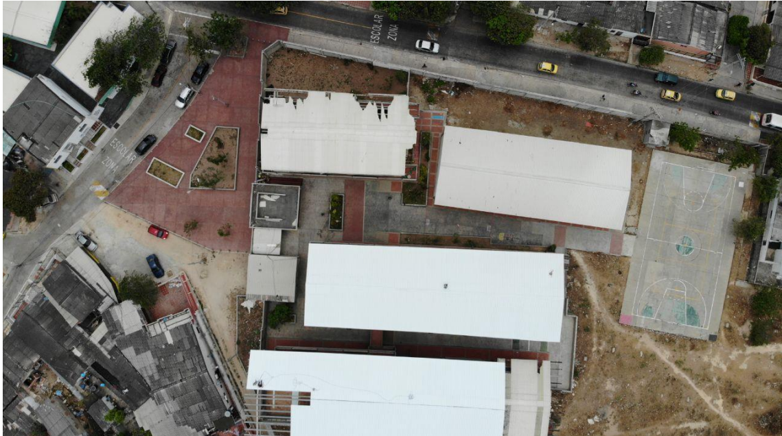
Cambio de cubierta IED CARLOS MEISEL 3 BLOQUES
