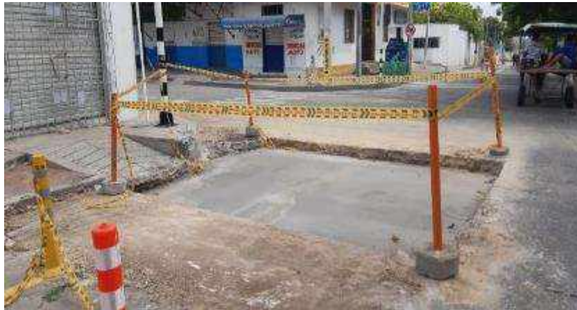
Actividades de instalación de concreto acelerado.
