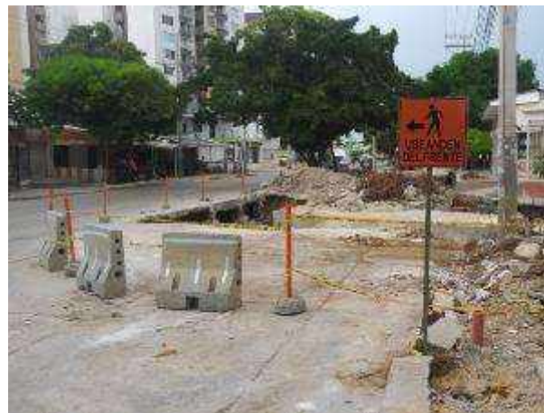
Obras complementarias en la Carrera 8 por Calle 33A
