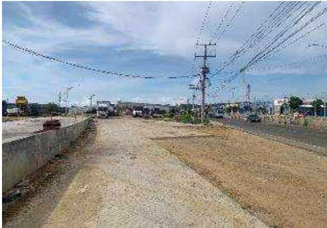
Construcción calzada de servicio occidental a la altura de la Carrera 27. Vista al norte.
