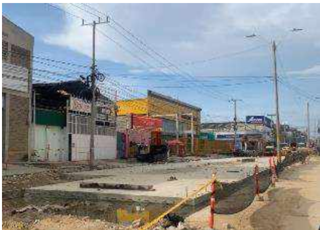
Ampliación de la calzada occidental de la Calle 30 entre Carreras 21 y 28
