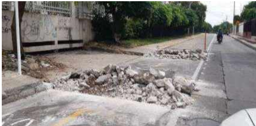
Actividades de limpieza de la zona y cerramiento de la obra.
