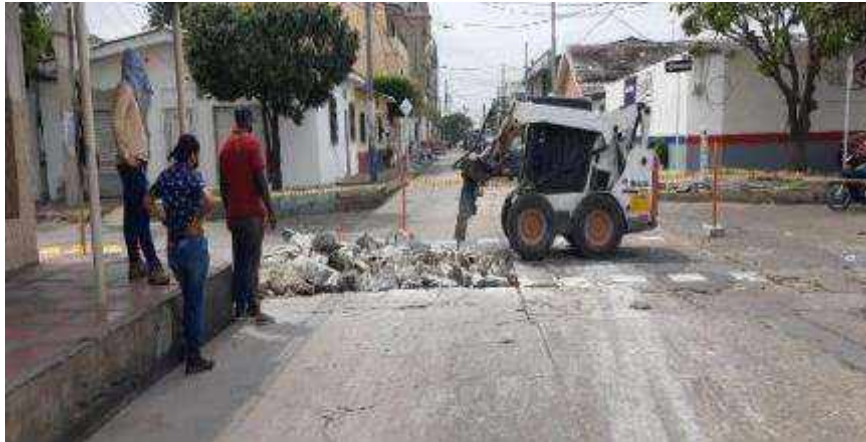
Actividades de acopio de escombros.
