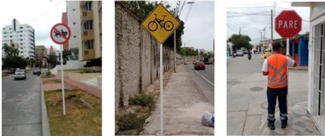
Ilustración 8 Registro fotográfico de instalación y mantenimiento de señales verticales
