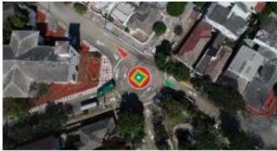
Calle 52 por carrera 66 - Mini glorieta Iglesia de Guadalupe
