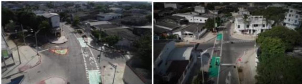
Ilustración 6 Demarcación ciclorruta barrio San José
