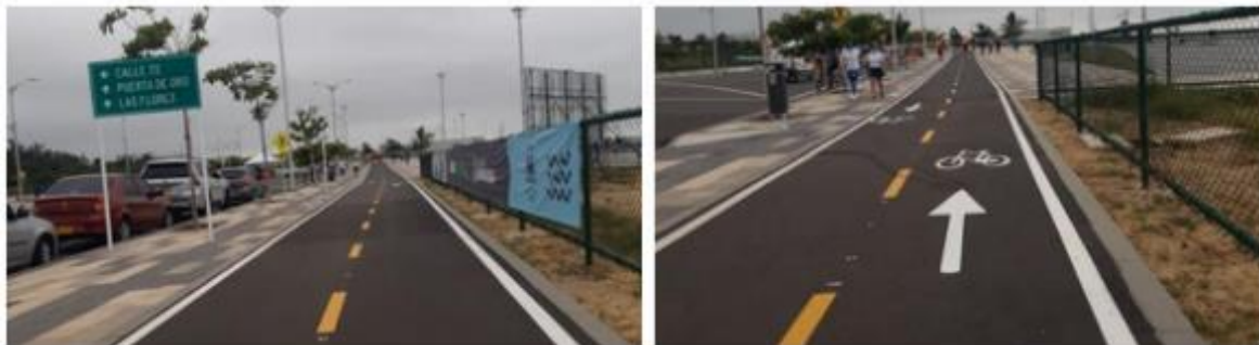
Ilustración 7 Demarcación ciclorruta Malecón entre calle 72 y monumento aleta de tiburón
