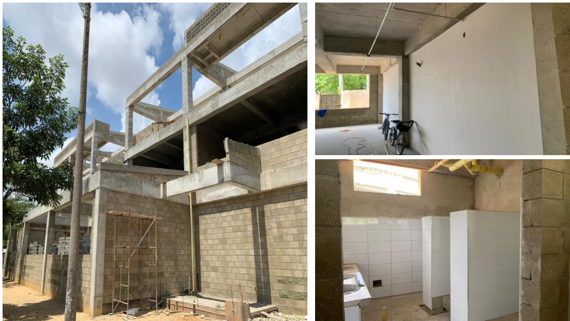
Seguimiento de obra - IED José Martí - el proyecto tiene un avance del 88.37%
