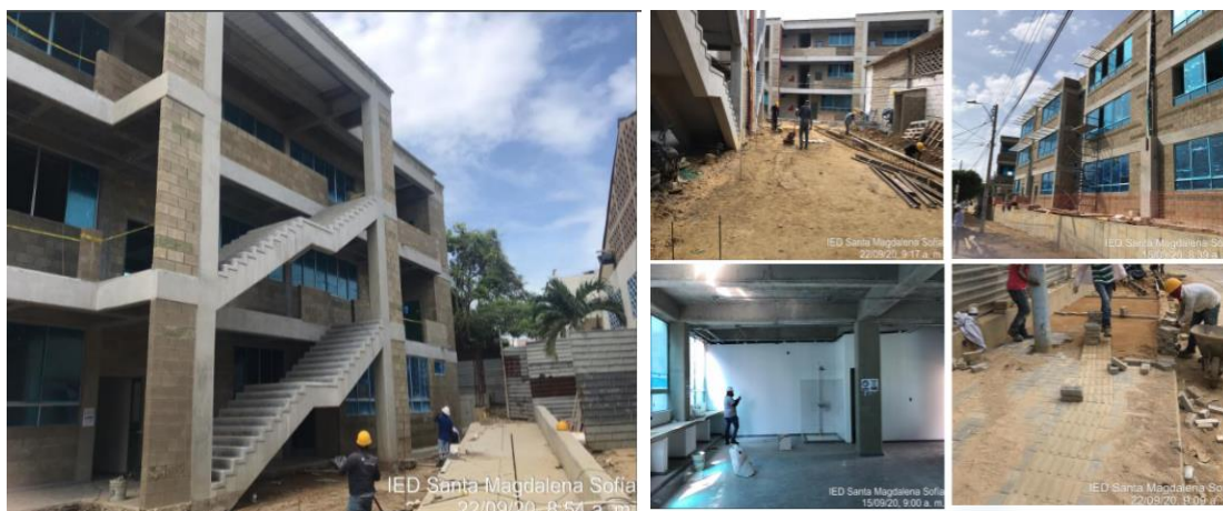
Seguimiento de obra - IED Santa Magdalena Sofia - el proyecto tiene un avance del 88.37%
