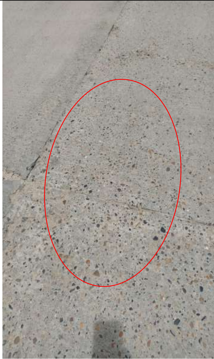
Calle 18 entre carreras 18 y 17 sabanalarga atlantico
