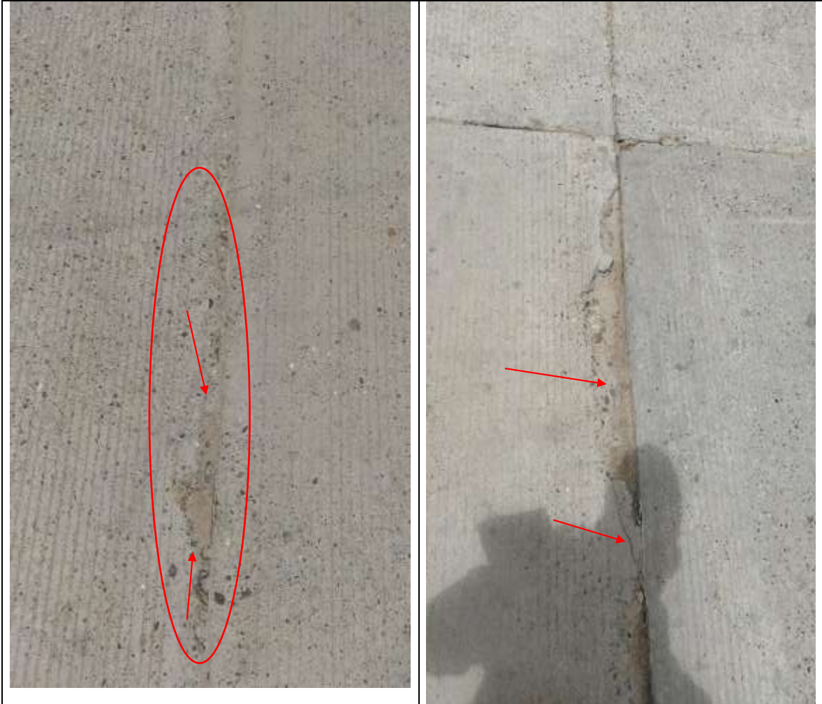
Calle 18 entre carreras 18 y 16 sabanalarga atlantico
