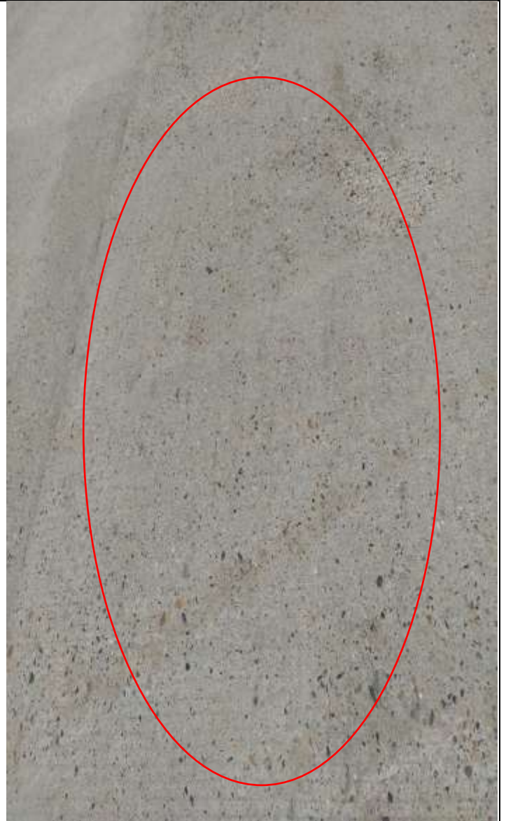
Calle 18 entre carreras 17 y 14 sabanalarga atlantico
