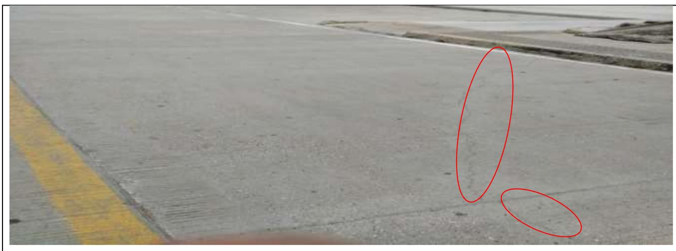
Vista de agrietamiento longitudinal (GL) en la calle 12 carrera 11A municipio de candelari
