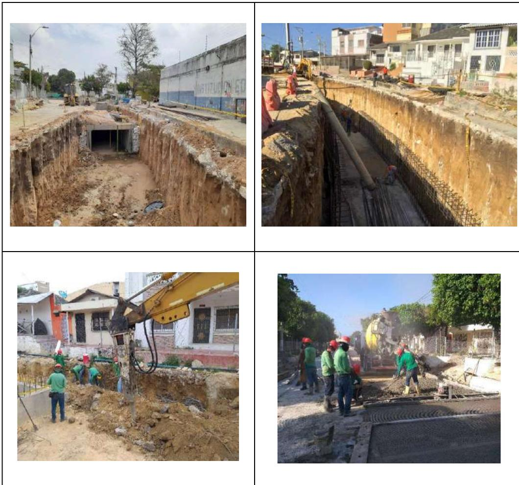
Figura 20.2.1 Construcción de canal, Boxculvert, demolición de pilote y fundida de pavimento.
