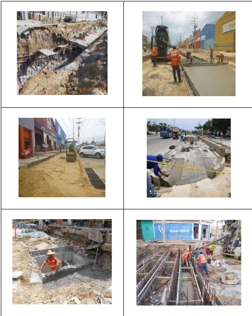
**Figura 21.4.1** Construcción de canal Cra 24 y 25, pavimentos, andenes, construcción de registro para banco de ducto y sumidero para colectas de aguas lluvias.
