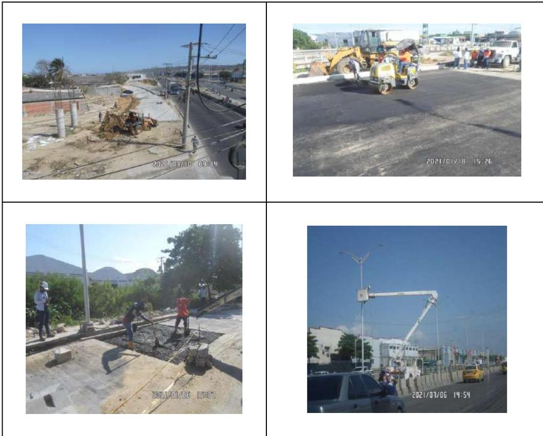
**Figura 21.3.1** Compactación de carpeta asfáltica, vaciado de losa de pavimento rígido, labores de reparación de sistema de alumbrado publico
