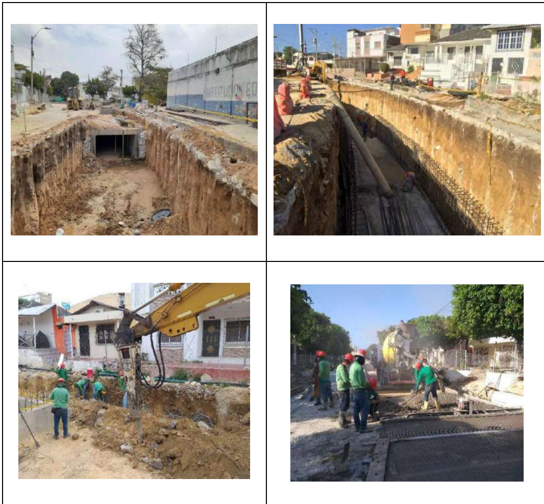
Figura 20.2.1 Construcción de canal, Boxculvert, demolición de pilote y fundida de pavimento.
