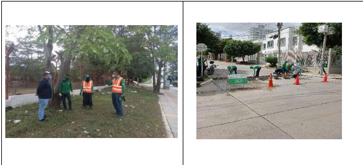
Figura 19.5.0 Dotación de elementos de bioseguridad.
