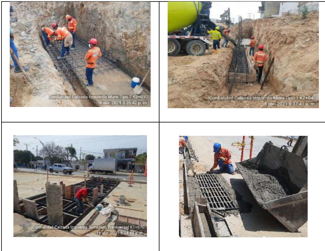
Figura 21.2.2 Conformación de andenes, construcción de pavimento, construcción de muro de contención, banco ducto para instalación de redes, sumideros para el manejo de las escorrentías pluviales.
