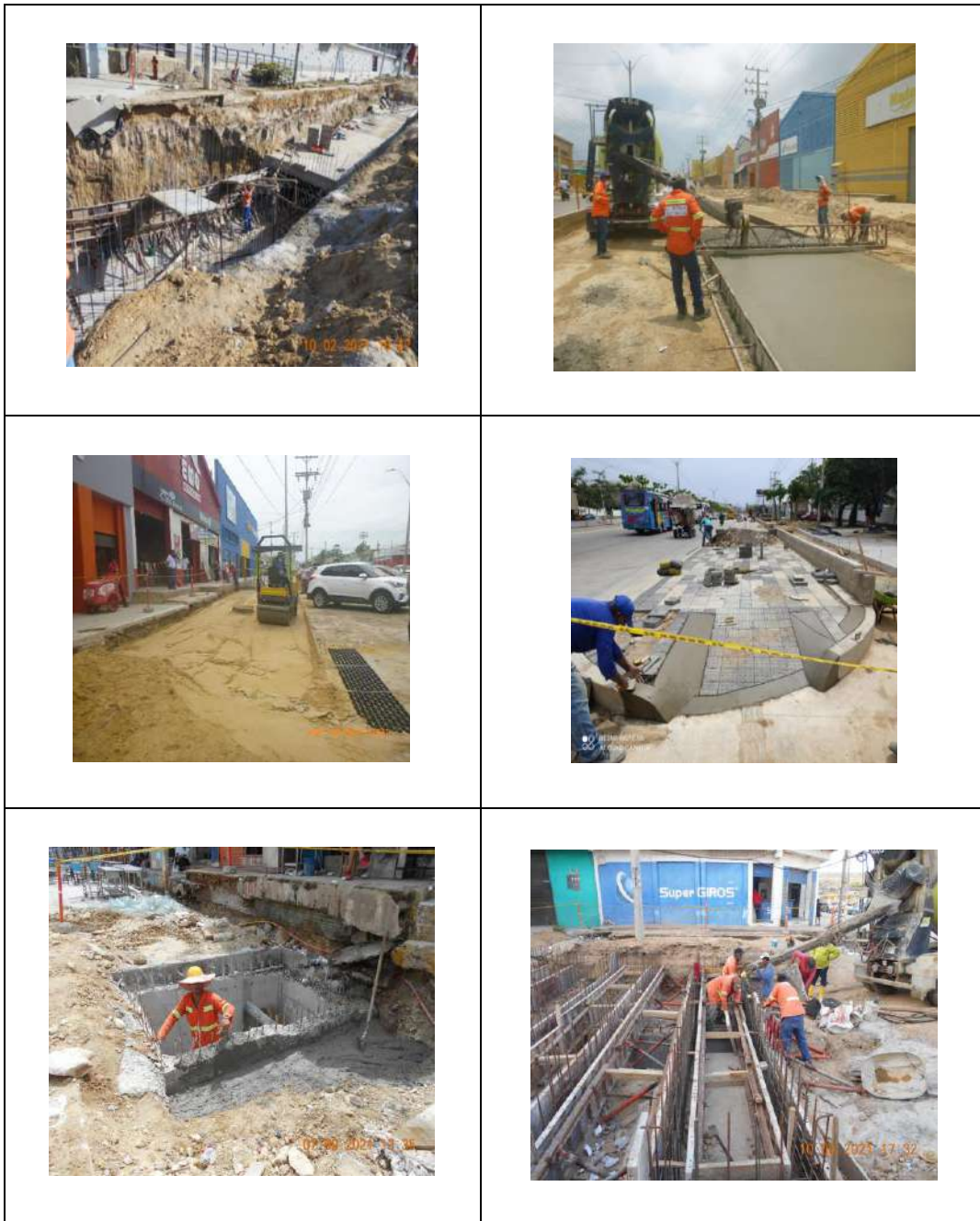
Figura 21.4.1 Construcción de canal Cra 24 y 25, pavimentos, andenes, construcción de registro para banco de ducto y sumidero para colectas de aguas lluvias.
