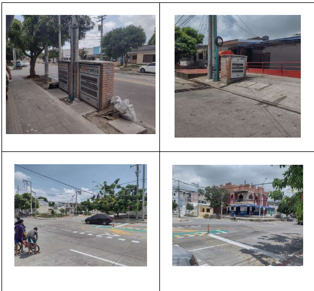
Figura 20.1.1 Construcción de nichos de gabinetes, intersección de la Cra 17 con la Cl 40
