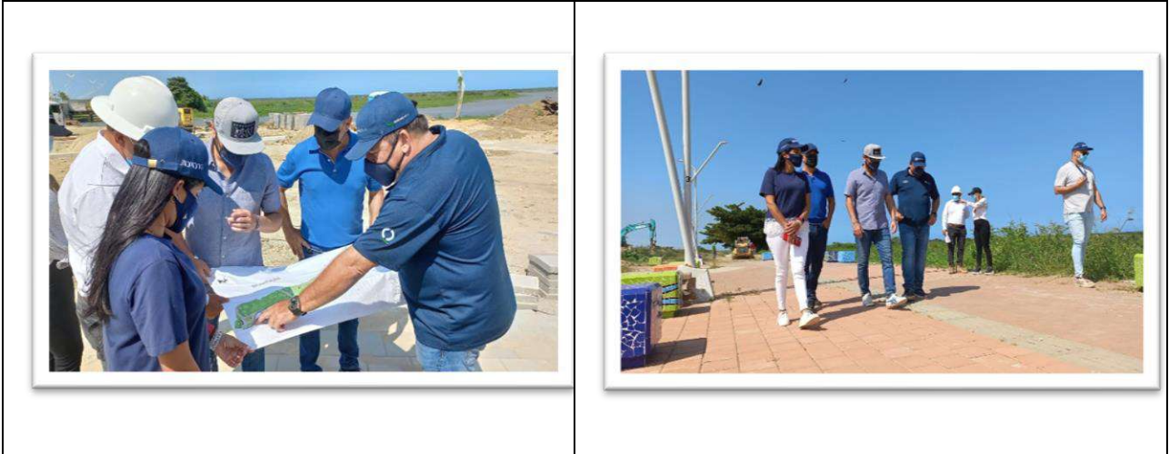
Figura 24.1.1 Inspección la Loma
