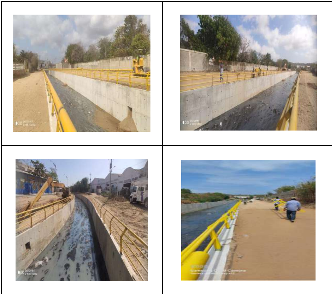
Figura 20.5.1 zonas de reconstrucción y canalización del arroyo de hospital
