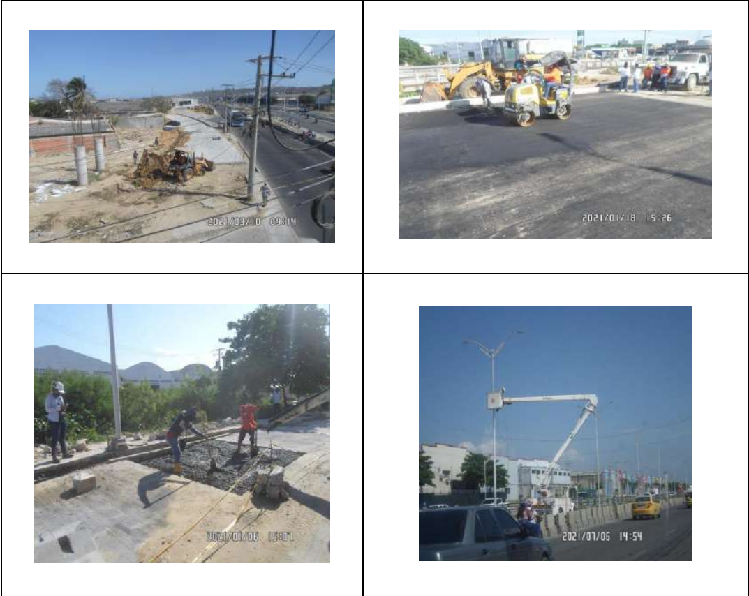
Figura 21.3.1 Compactación de carpeta asfáltica, vaciado de losa de pavimento rígido, labores de reparación de sistema de alumbrado público
