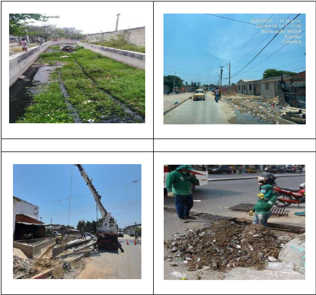
Figura 20.4.1 Limpieza de estructura del caño, viviendas intervenidas, instalación de postes, limpieza de estructura de captación.
