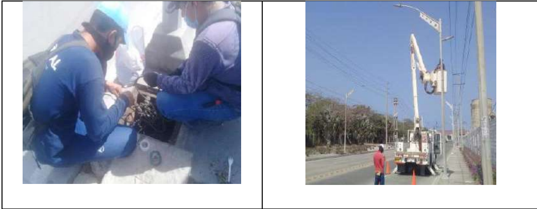
Figura 21.1.1 Instalación de cables eléctricos, Instalación de conectores sumergibles y conectores Split Bolt, cambio de luminarias peatonales.
