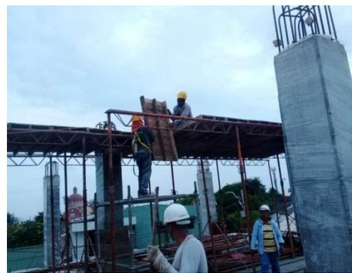
Inicio de la instalación de formoletas para plataforma de fundida de vigas aéreas.
