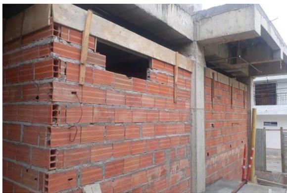
Fundida de viguetas de confinamiento de muros.
