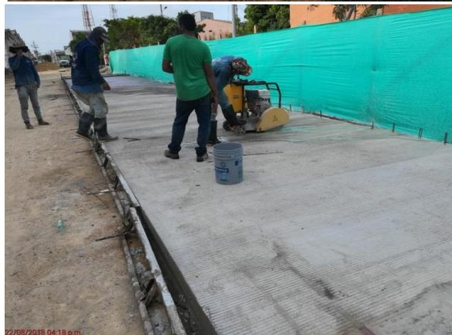
Conformación de material de suelo cemento (Calle 108, entre Carreras 33-34) y Labores de corte de losa de pavimento rígido (Calle 108).
