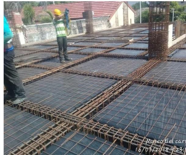
Vista de instalación de icopor y acero de refuerzo para losa de entrepiso.
