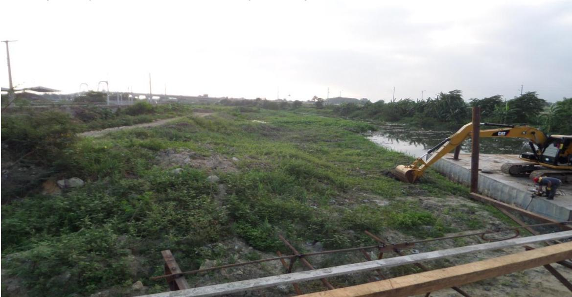
**Foto 1:** en la fotografía se puede observar la etapa preliminar donde se inicia el proceso de limpieza y excavación en el caño de la ahuyama y la cantidad de sedimento y vegetación presente en el afluente obstaculizando el libre movimiento del agua y produciendo olores ofensivos debido al estancamiento de las aguas y además afectación a la población residente en el lugar por inundaciones.
