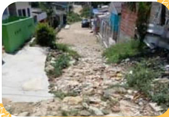
Calle 85 entre carrera 15 b y 15 c
