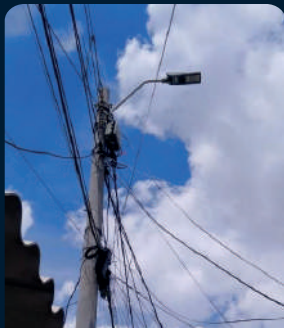
Calle 118A No 22- 20. Barrio Los Ángeles, luminaria reparada
