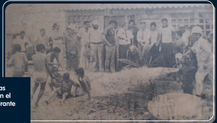
Problemática de poza séptica que se desbordaba por los aguaceros e inundaba las calles y viviendas de la Urbanización El Pueblo.
