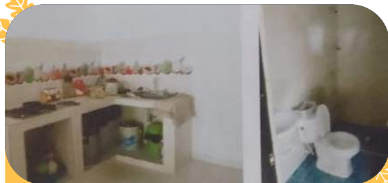
Estado actual al interior de la vivienda en el barrio Los Rosales con intervención
