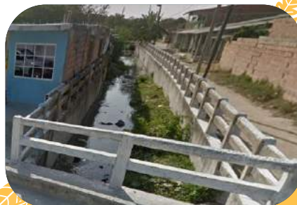
Arroyo canalizado en la calle 80 entre carreras 9C y 9D
