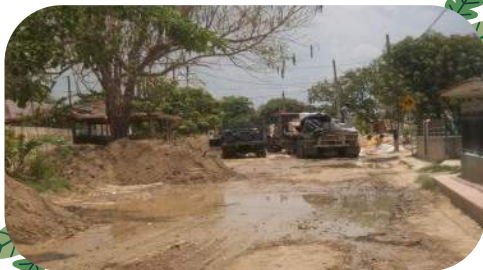
Obras de canalización sobre el arroyo León, 2011. Foto de Jesús Rico
