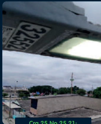
Cra 25 No 25 21: instalación de conectores.
