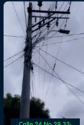
Calle 24 No 29 32: luminarias reparadas.
