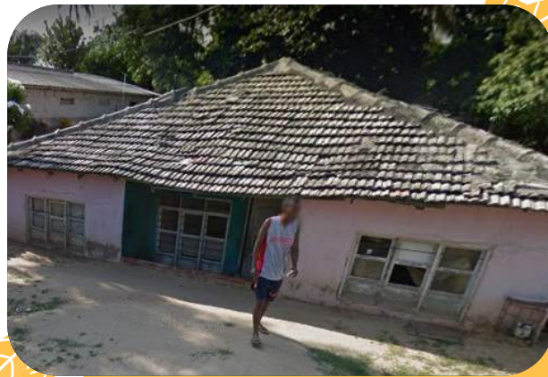
Antigua vivienda sin mejoramiento en la carrera 86 con calle 85
