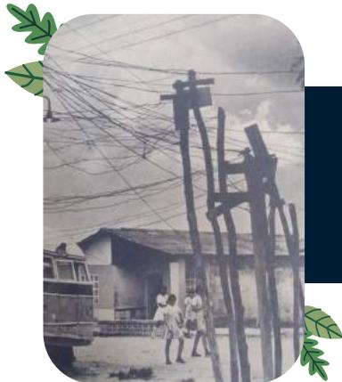
Fotografía del Diario La Prensa tomada por Samuel Pérez. Se observa la postería levantada por los moradores del tugurio La Chinita y cómo tomaban los cables de la electrificadora para realizar conexiones hacia sus viviendas, con el fin de acceder al servicio de energía eléctrica. También se observa la carrocería de un bus en la calle y las condiciones de abandono del transporte en 1977.
