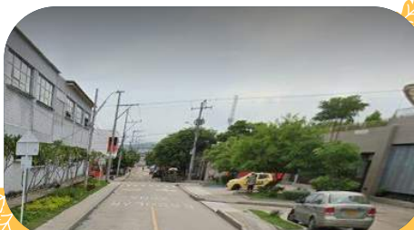
ACTUAL CARRERA 26 CON UN MEJORAMIENTO EN LA INSTITUCIÓN EDUCATIVA BETSABÉ ESPINOSA, PASO LA PRADERA Y SIEMBRA EN ARBOLES EN EL ANDÉN. FUENTE: GOOGLE MAPS
