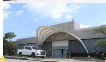
PASO LA PRADERA. CARRERA 26 ENTRE CALLES 120 Y 121. AHORA
