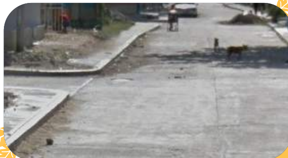
PAVIMENTACIÓN DE LA CARRERA 20 A LA ALTURA DE LA CALLE 121 A. FUENTE: GOOGLE MAPS
