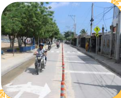
ACTUAL SEPARADOR VIAL EN LA CARRERA 20 A LA ALTURA DE LA CALLE 115 ENTRE LOS ANGELES I Y LOS OLIVOS II
