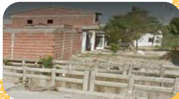
CANALIZACIÓN DE ARROYO EN EL GOLFO. FUENTE: GOOGLE MAPS
