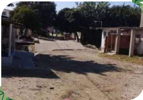
Antigua carrera 21 con calle 85
