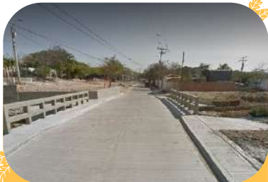
ACTUAL PUENTE CONSTRUIDO Y SIN RIESGOS PARA LA COMUNIDAD
