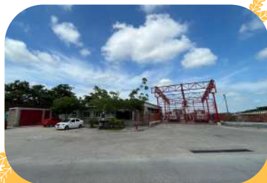
ESTACIÓN DE BOMBEROS DE EL EDÉN
