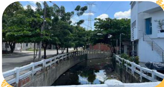
ARROYO CANALIZADO (CARRERA 13 CON CALLE 109 A)
