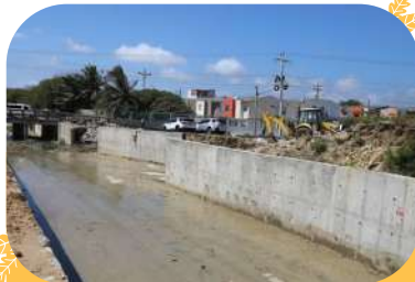
ACTUAL CANALIZACIÓN DEL ARROYO EL SALAO II
